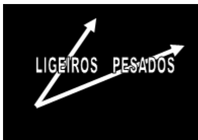
Figura 4.26 – Marcas rodoviárias no pavimento a evidenciar a separação de veículos
