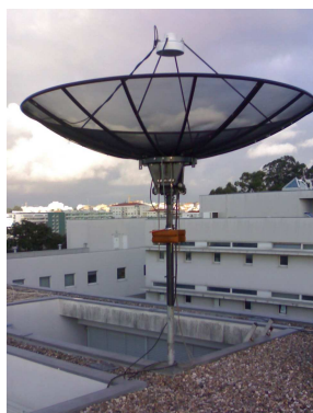
Figura 2.17- Antena na posição de segurança
