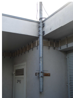
Figura 4.1- Mastro de fixação situado no topo do edifício I-Nascente
