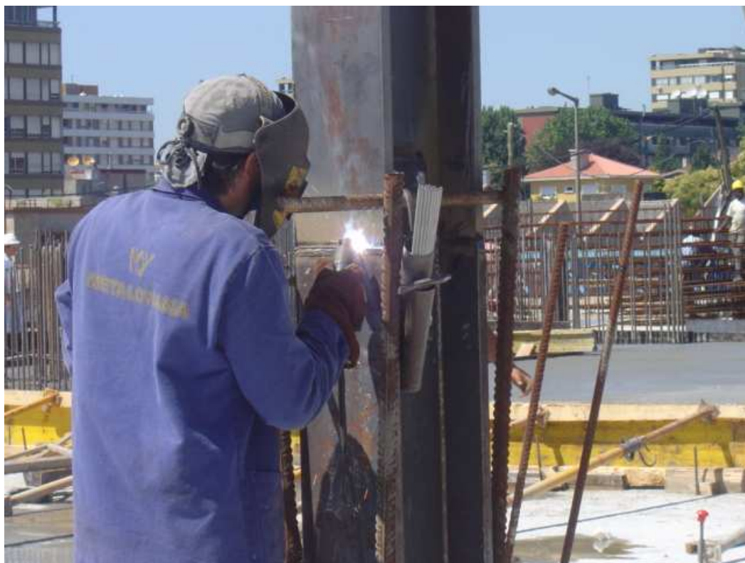
Figura 2.16 – Ligação entre perfis dos pilares mistos
