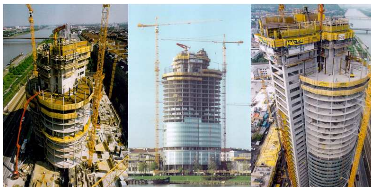
Figura 2.9 – Progresso da construção
