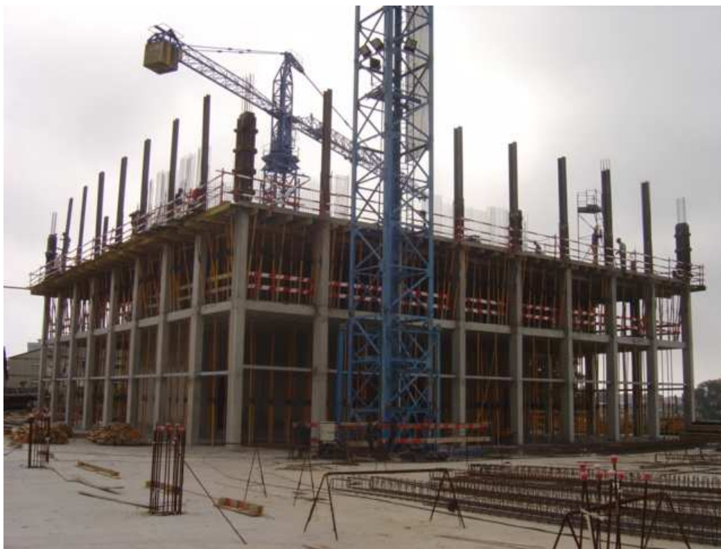
Figura 2.14 – Construção dos pilares da torre
