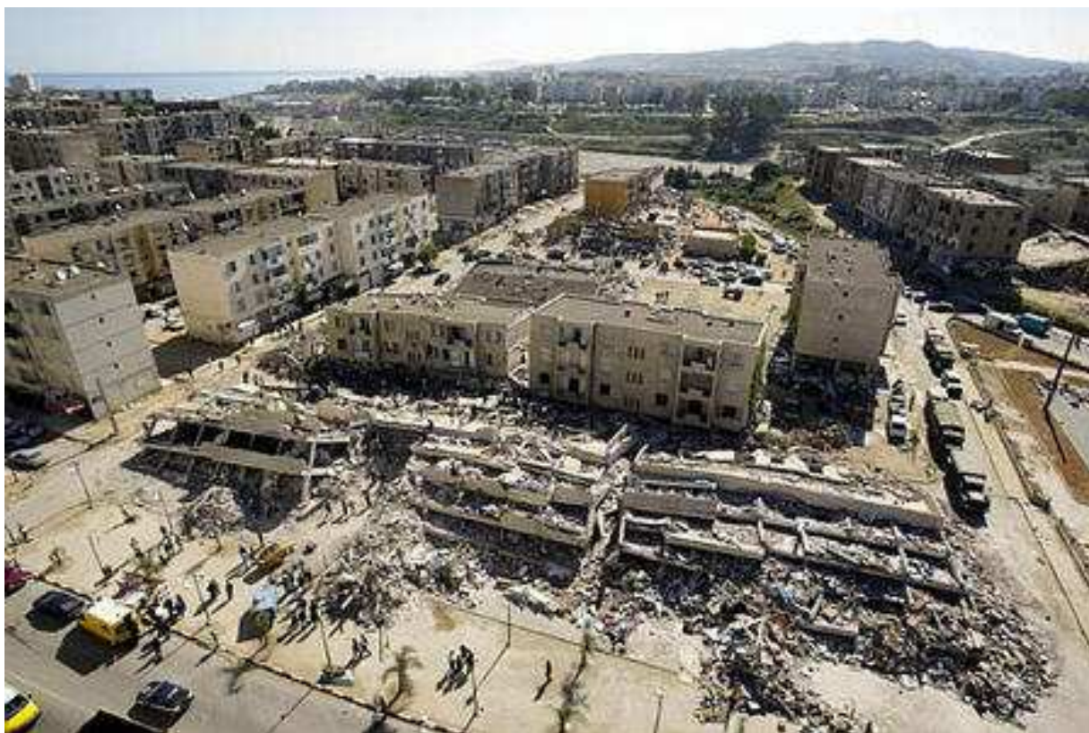
Figura 1. 1 – Consequências do sismo de Boumerdès, Argélia (2003).
