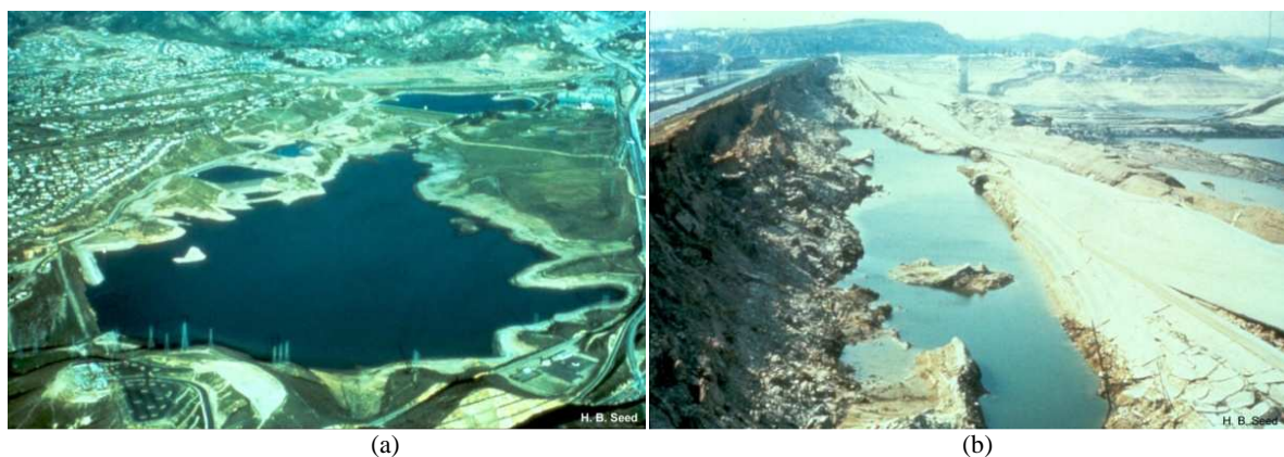
Figura 2. 6 – a) Barragem de São Fernando intacta; b) destruição do talude de montante devido à liquefacção.
