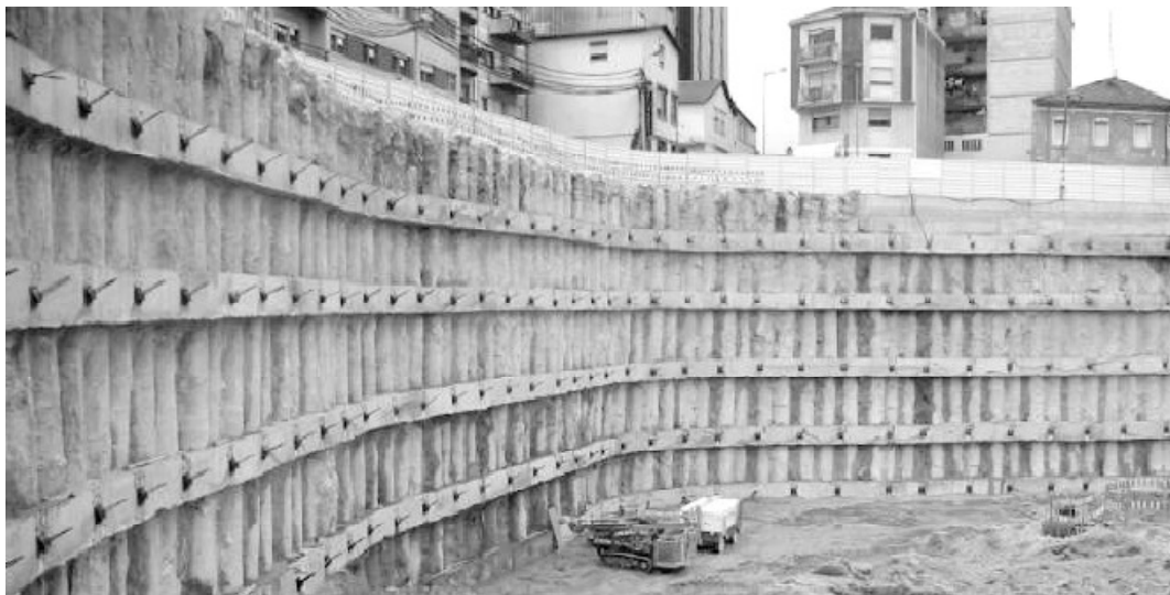
Fig. 3.13 - Vista parcial da contenção (Mota-Engil Engenharia, SA)
