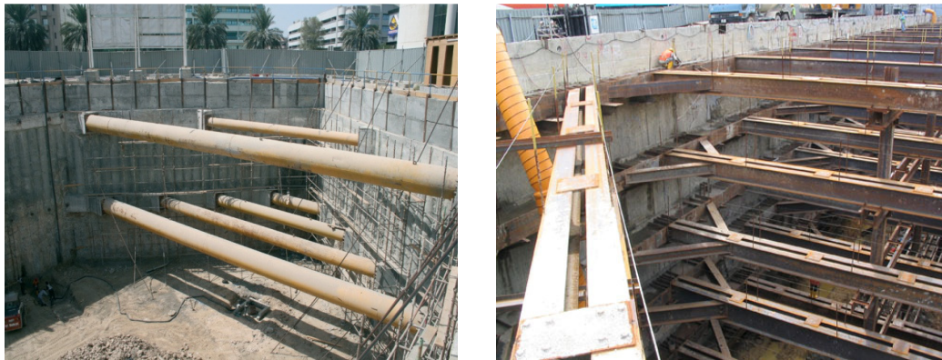
Fig 2.3 - Exemplos de escavações multi-escoradas (PlanningEngineer, 2003)
