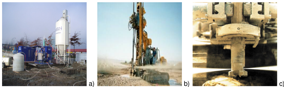
Fig 3.2 - Equipamento utilizado na técnica de jet grouting : a) central de calda e cimento e compressor; b) sonda hidráulica com torre; c) vara de jet grouting : coroa e respectivos jactos (Matcon, 2004)
