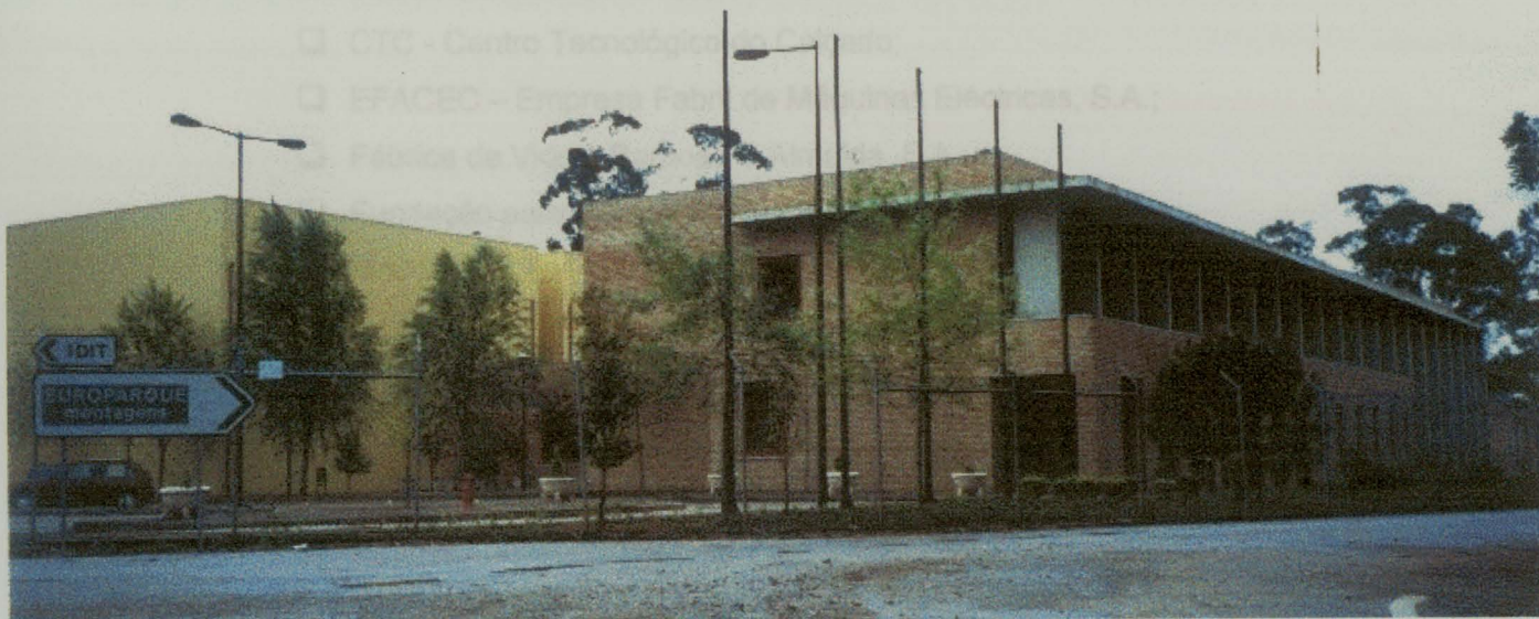
Figura 1. Fachada principal do IDIT.
