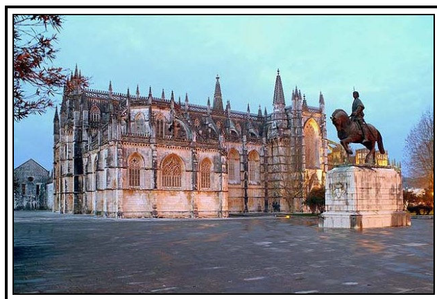
Fig. 2.9 – Mosteiro da Batalha (Santa Maria da Vitória)
