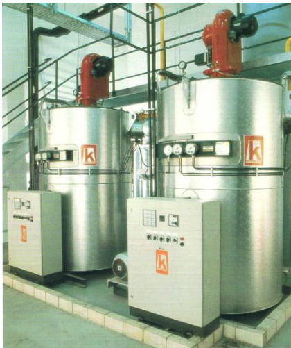
Figura 3.8 – Duas caldeiras verticais que queimam gás. No seu interior circula fluido térmico por intermédio de serpentinas.
