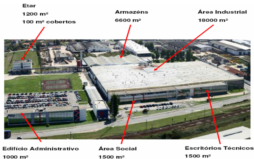
Figura 2- Instalações actuais da BBT termotecnologia
