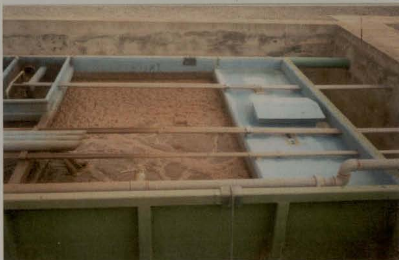
Figura 21 – Digestor de lamas da ETAR de Areias de Vilar.
