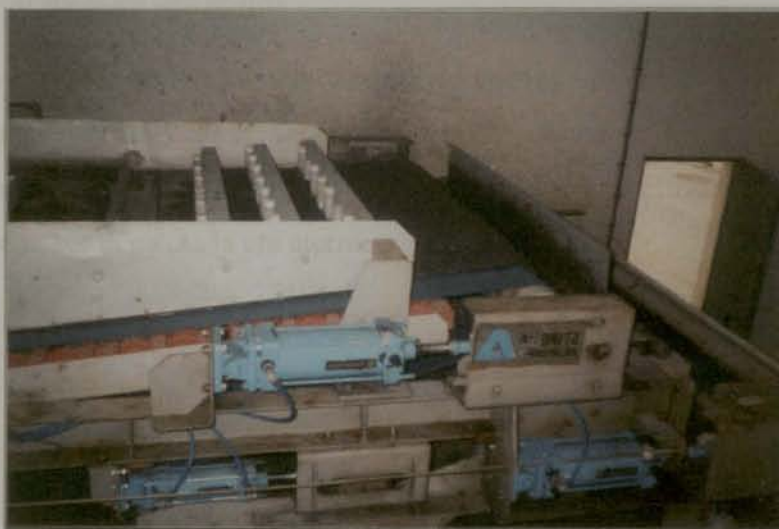
Figura 13 – Filtro de bandas: entrada das lamas.
