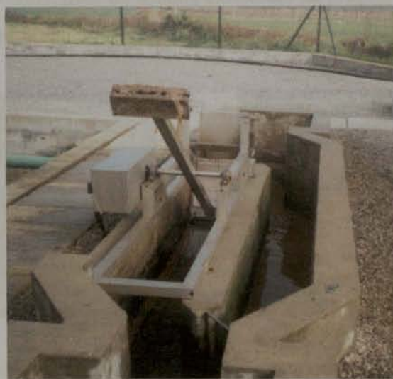
Figura 16 – Grade mecânica da ETAR de Areias de Vilar.
