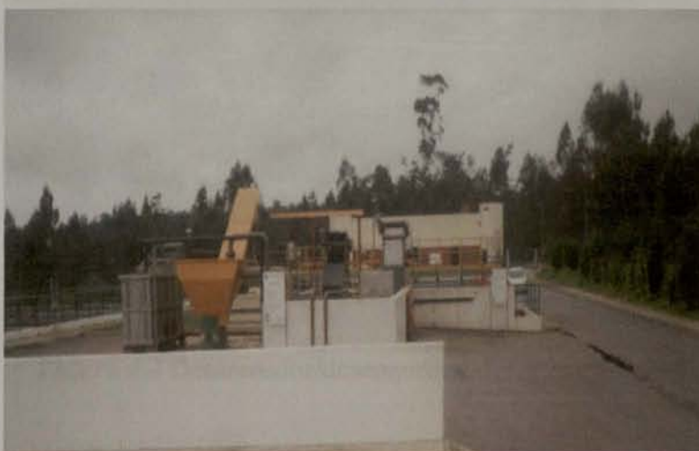
Figura 3 – Obra de entrada.
