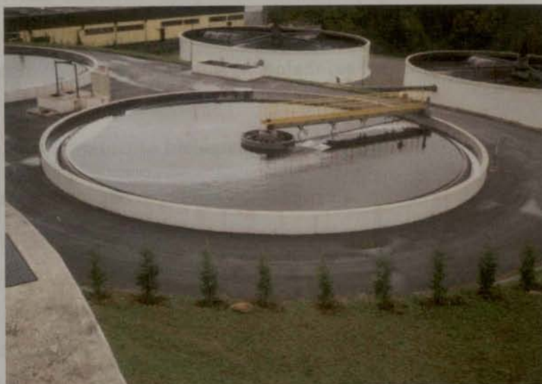
Figura 8 – Decantador primário.
