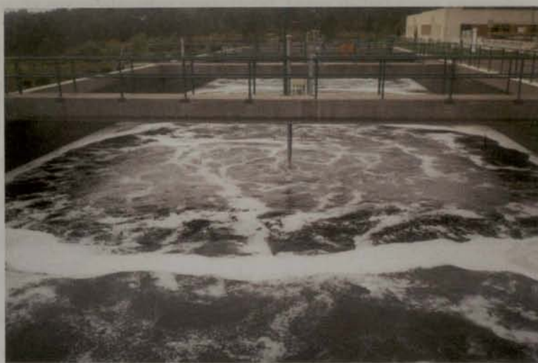
Figura 5 – Tanque de homogeneização.
