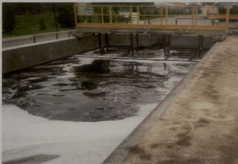
Figura 4 – Desarenador/desengordurador.
