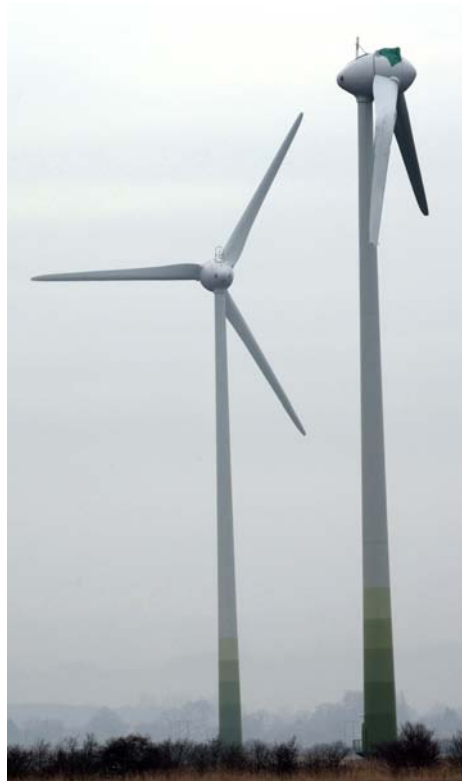
Figura 1.1: Falha estrutural num aerogerador
