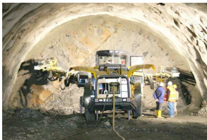
Fig. 2.2 – “Jumbo” durante o processo de furação para a instalação de explosivos [2]
