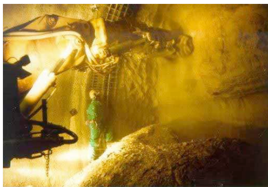
Fig. 2.10 – Escavação do túnel com uma roçadora [7]
