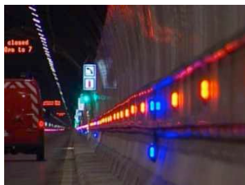
Fig. 5.6 – Iluminação de evacuação [51]
