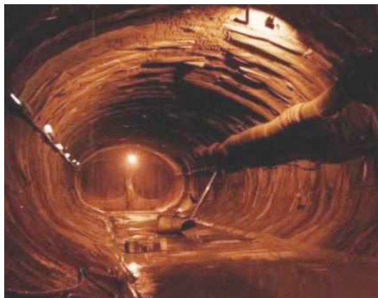
Fig. 2.12 – Observação das deformações do túnel [7]
