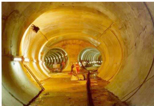
Fig. 2.13 – Aplicação do suporte secundário ou definitivo [7]
