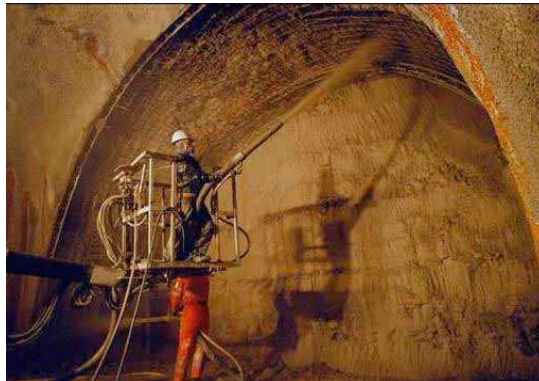
Fig. 2.11 – Aplicação da camada de betão projectado com malhasol [7]
