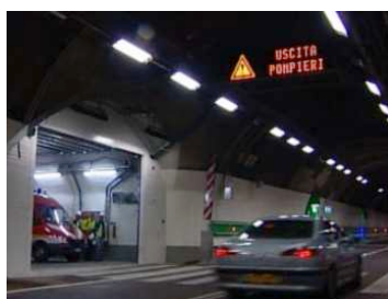
Fig. 5.4 - Ligação transversal utilizada pelos serviços de emergência [51]
