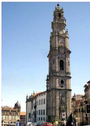
Figura 2.18 – Torre dos Clérigos [8].
