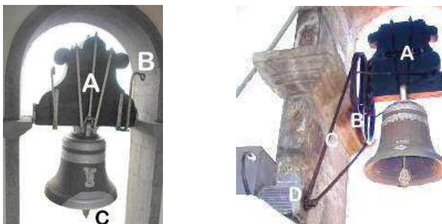
Figura 2.15 – Bamboar um sino manualmente (à esq.) e electricamente (à dir.) [1].
