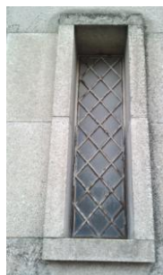
Figura 3.9 – Aspecto de uma janela da Torre.
