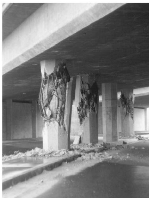
Fig. 2.8 – Armadura transversal insuficiente (Chen e Duan, 2003).
