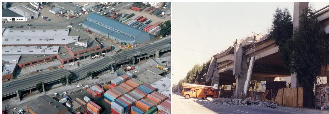
Fig. 2.11 – Sismo de Loma Prieta (1989, EUA). Colapso do viaduto “Cypress”.
