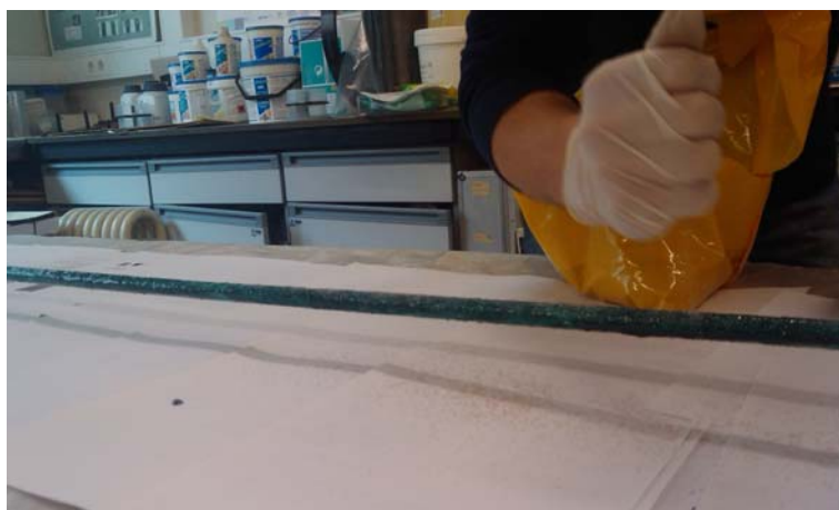
Figura 5.2 – Aplicação do revestimento.
