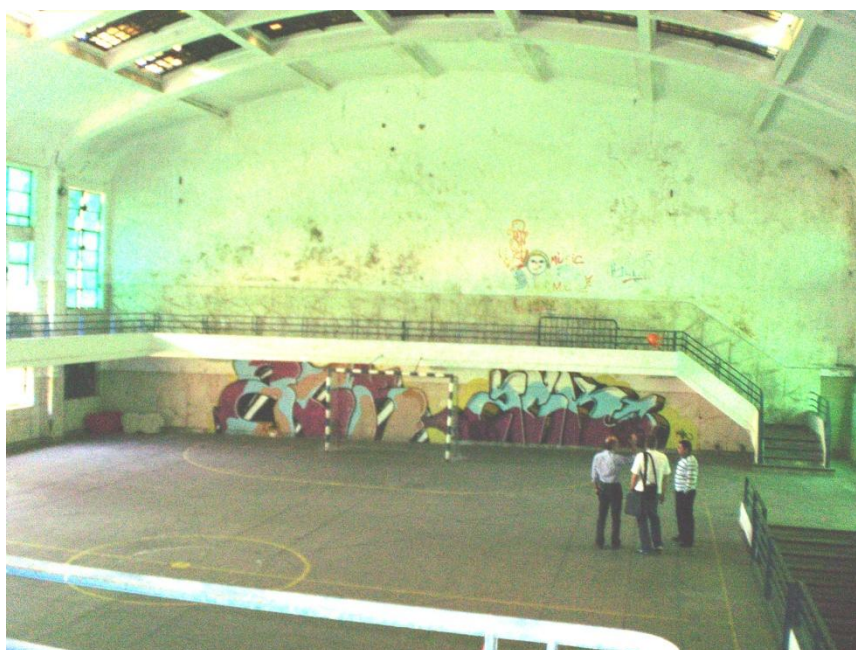
Fig.3.17. – Grande nave com vistas da galeria ao fundo
