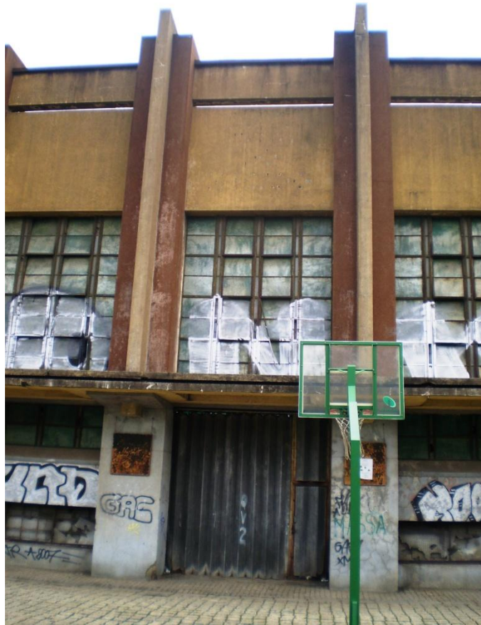
Fig.3.13. – Entrada da Lota do Entrepósito Frigorífico do Peixe
