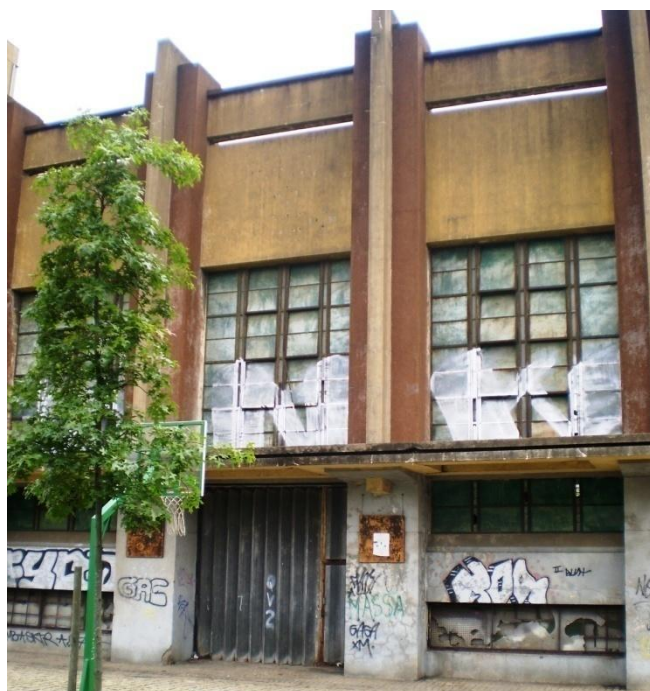
Fig.3.9. – Continuação da fachada virada para a Alameda de Basílio Teles
