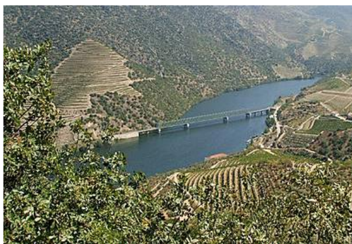
Fig.2.2. – Ponte da Ferradosa
