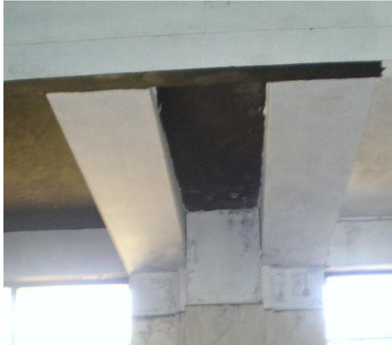
Fig.3.23. – Cachorros onde assenta a galeria
