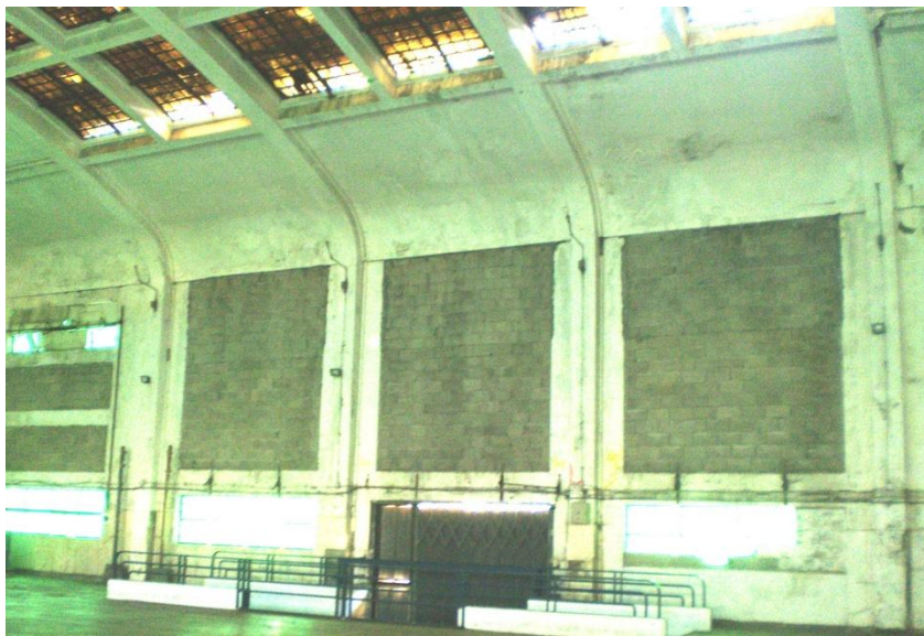
Fig.3.22. – Pórticos onde a cobertura se apoia
