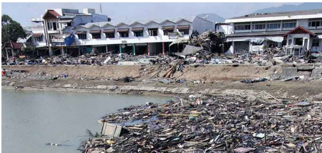
Fig.2.7 – Danos devidos ao sismo de 2005, Sumatra, Indonésia.
