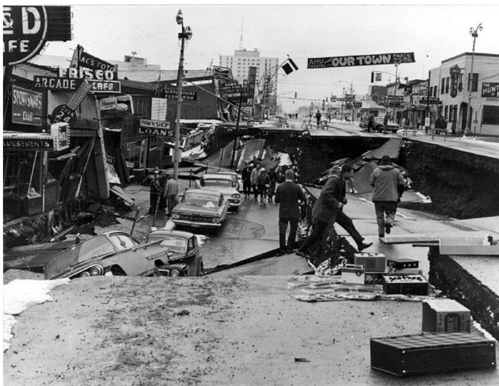
Fig.2.2 – Danos provocados pelo sismo de 1964 no Alasca.
