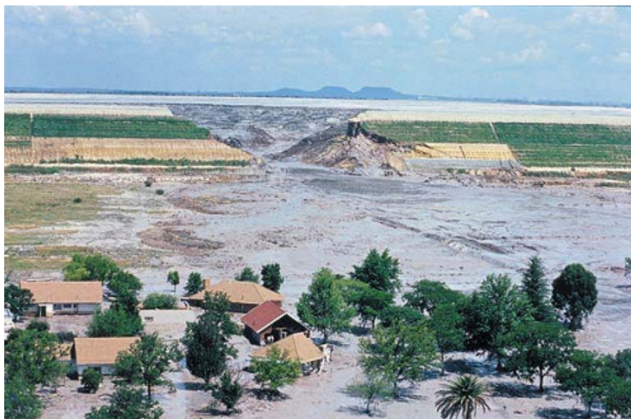
Fig.2.13 – Falha devida à liquefacção estática na barragem de resíduos do ouro (Merriespruit, África do Sul, Fevereiro 2004)
