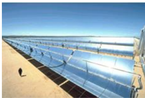
Figura 3.5: Colectores solares cilíndrico-parabólicos com 1 eixo de rotação
