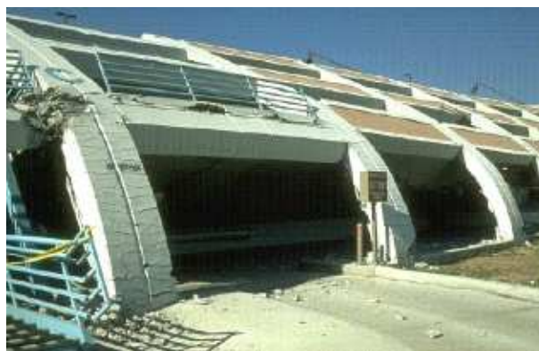
Figura 2.9 – Deformações plásticas a que um edifício pode ser sujeito (Clinton, 2005)
