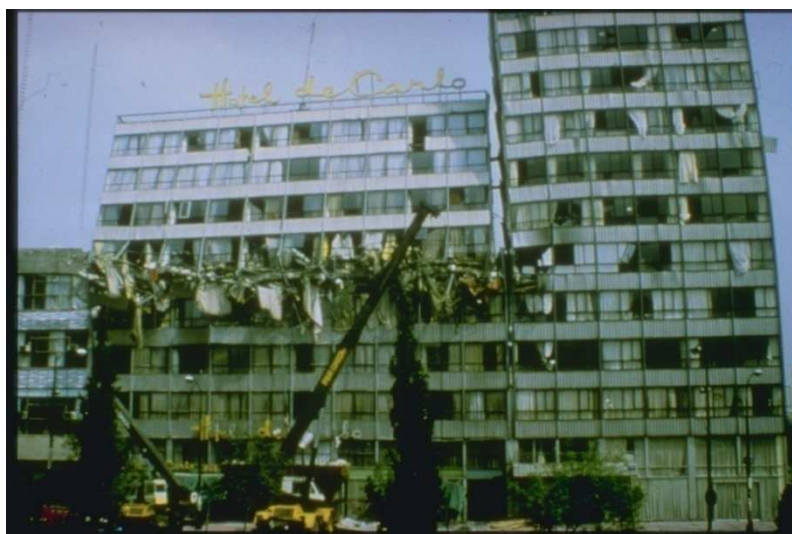
Figura 2.4 – Exemplo1 do fenómeno de Pounding ocorrido no México a 19 de SEembro de 1985 (National Geofisical Data Center, 2007)
