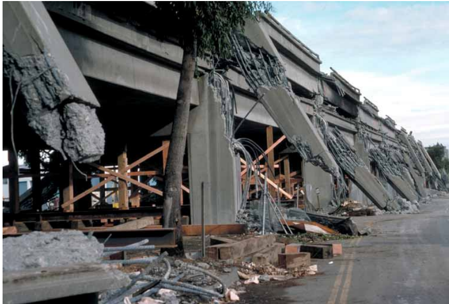
Fig. 2.7 – Falha dos nós de ligação [6].
