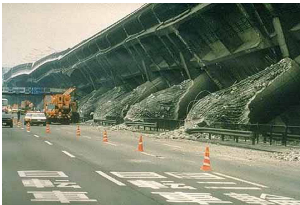
Fig. 2.4 – Colapso de um viaduto devido a dispensa prematura das armaduras longitudinais dos pilares [1].
