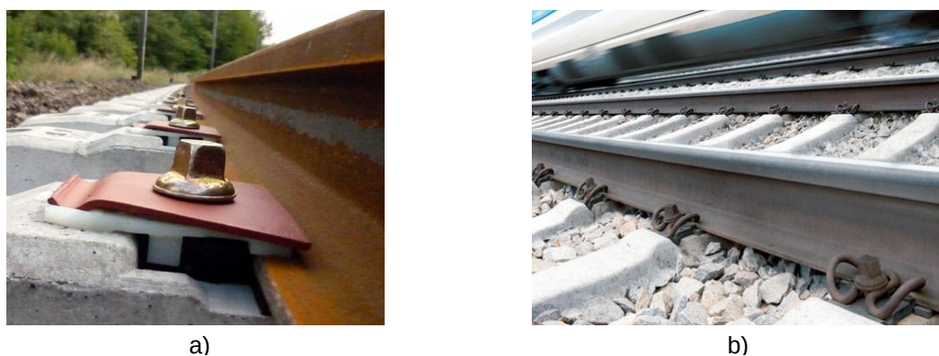
Fig. 2.6 – Elementos de fixação elásticos: a) Tipo nabla; b) Tipo Vossloh (Railway.Technology, 2010)
