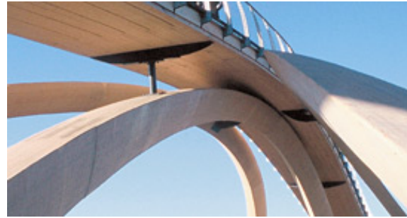
b) Pormenor de encontro dos 3 arcos
