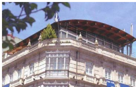
c) Novo piso na cobertura
