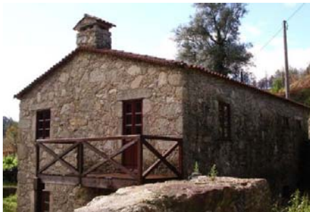
a) Construção alvenaria de pedra
