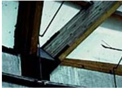
b) Suporte da viga de cobertura
