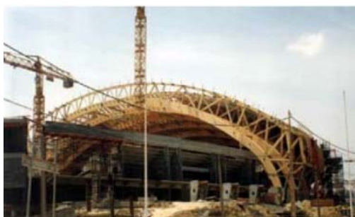
a) Construção da nave principal em MLC
