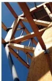
b) Pormenor de um arco transversal
