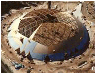
a) Construção da cúpula em MLC
