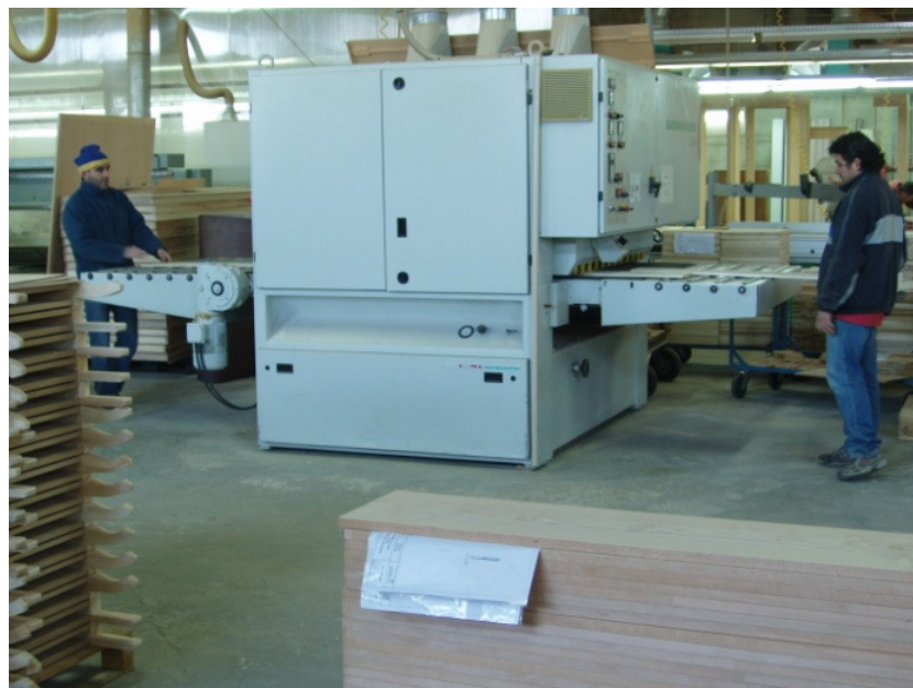
Fig. 84 - Vista geral da calibradora em funcionamento.
