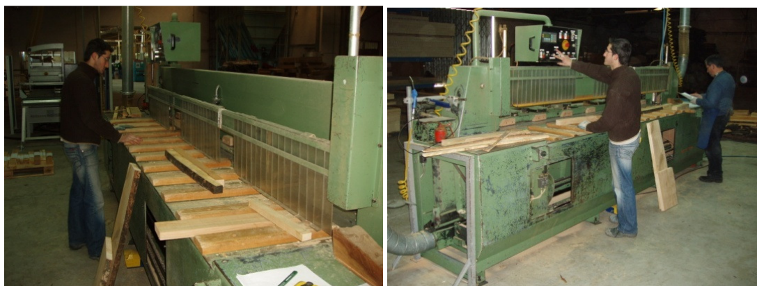
Fig. 73 – A esquerda imagem geral a equipamento de alinhar madeira, à direita operador a utilizar o equipamento
