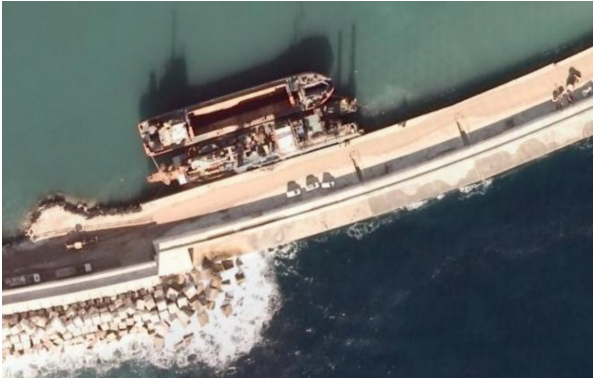
Fig. 4.4: Porto de Barcelona. Passagem de quebramar de taludes para quebramar vertical. Cais contínuo.
