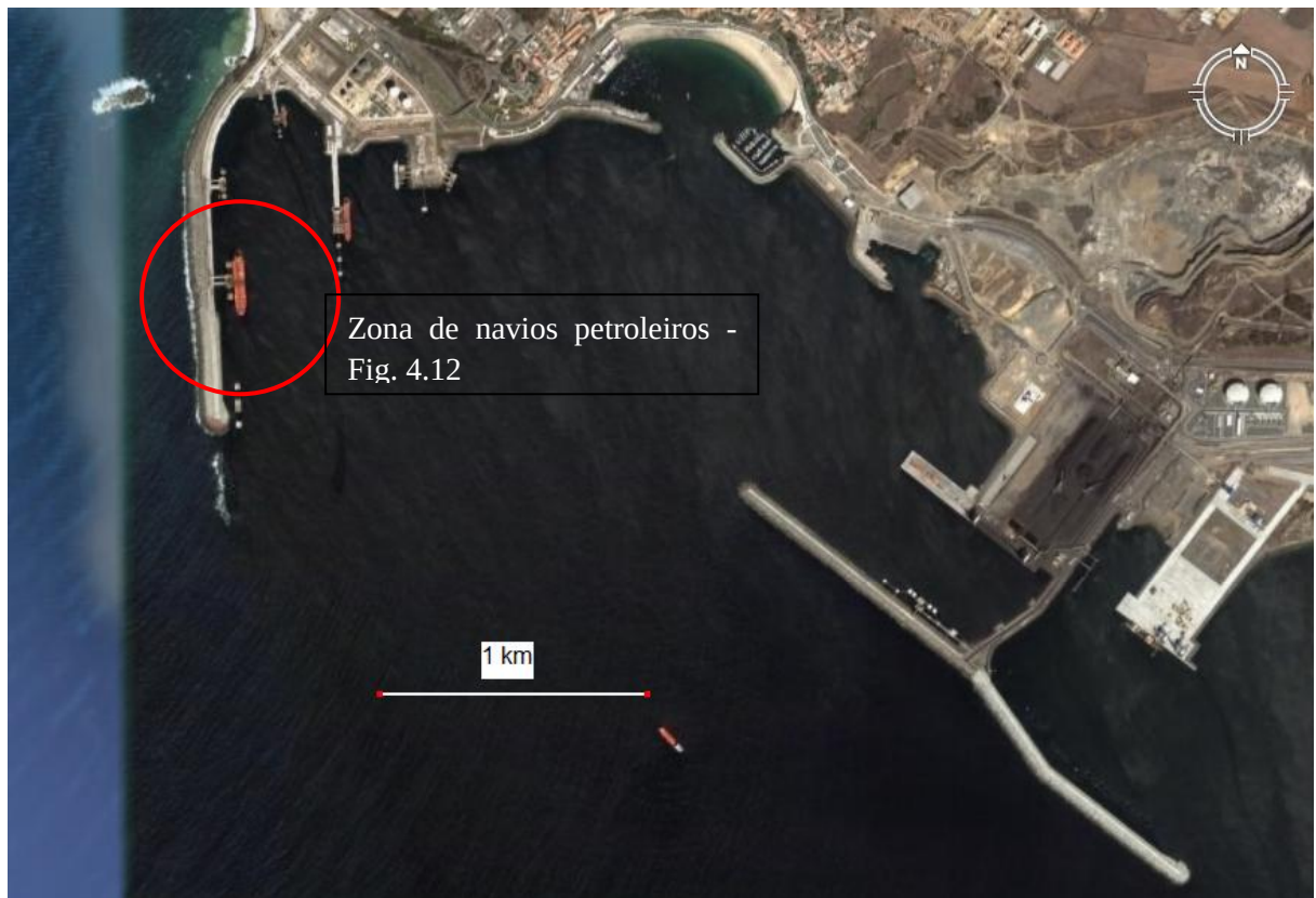
Fig. 4.11: Porto de Sines. Panorâmica do Porto de Sines.
