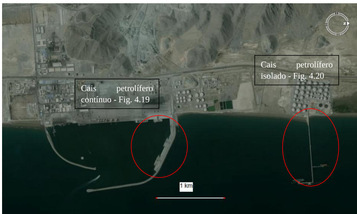
Fig. 4.18: Porto de Fujairah. Panorâmica do porto de Fujairah.
