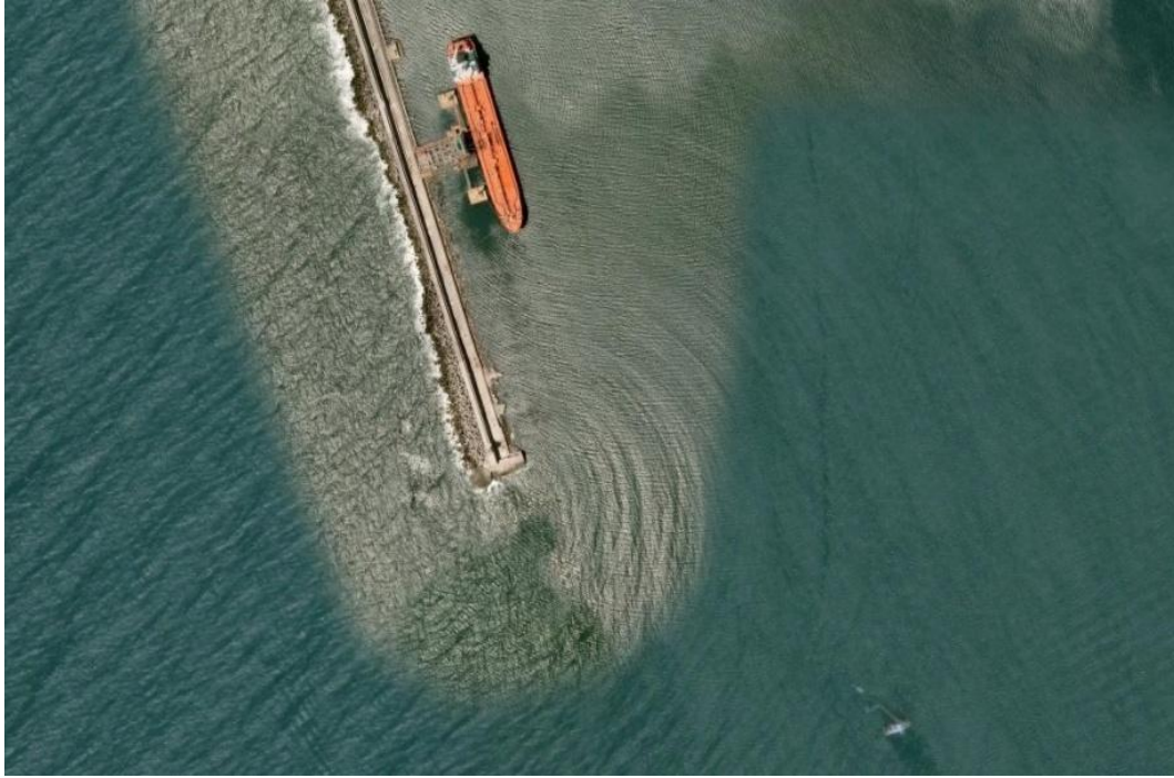
Fig. 4.40: Difracção das ondas na cabeça do quebramar Norte do porto de Leixões.
