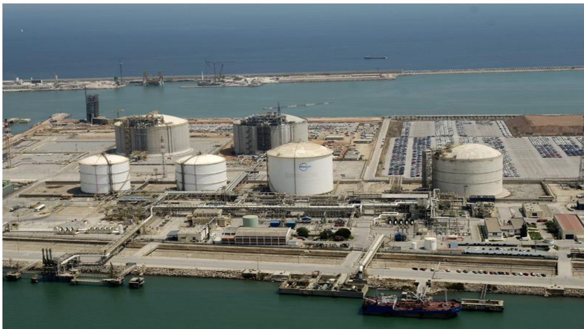
Fig. 4.2: Porto de Barcelona. Terminal de navios petroleiros – [11].
