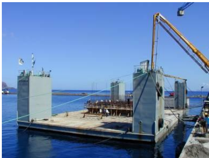
Fig. 5.4: Plataforma para construção dos caixotões – [27].
