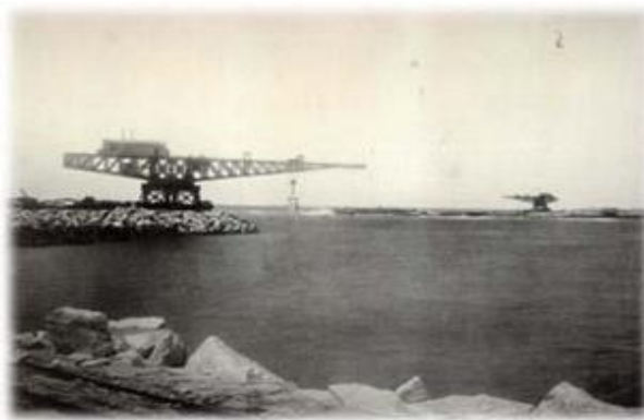
Fig. 2.2: Construção do Porto de Leixões (1884-1892) – Rochedos de Leixões e extremidades dos dois molhes – os Titãs de Leixões - [6].
