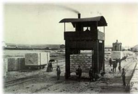
Fig. 2.4: Construção do Porto de Leixões (1884-1892) - Grua utilizada para erguer e transportar sobre carris os blocos artificiais de 50 toneladas, junto ao Senhor do Padrão – [6].
