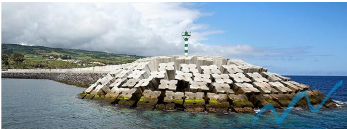
Fig. 5.2: Exemplo de colocação de blocos cúbicos Antifer – [26].
