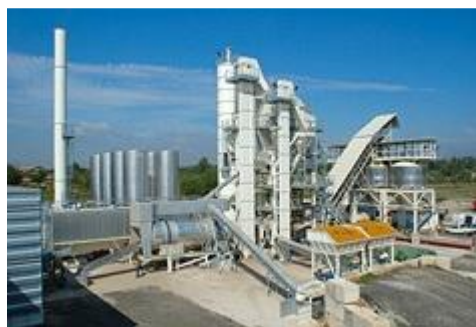
Figura 6. Imagem de central de fabrico de solo-cimento
