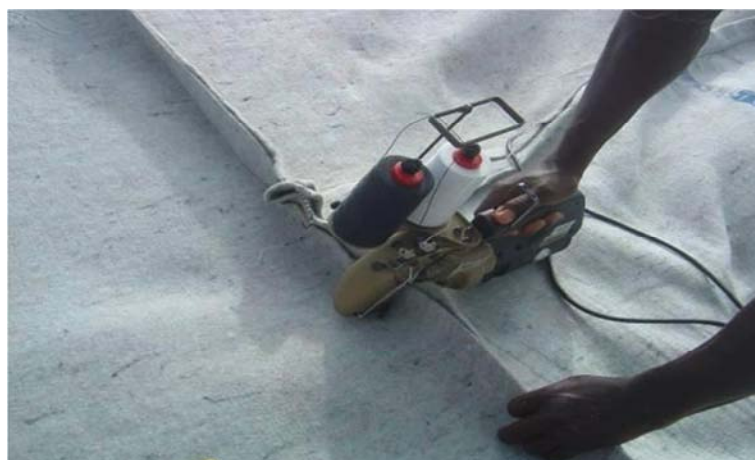
Figura 2.16 – Realização de uma junta simples no geocintento.
