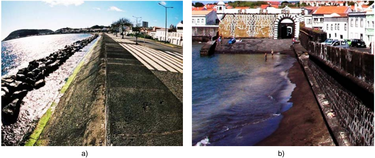
Figura 2.1 – Obra longitudinal aderente: a) frente litoral da cidade da Horta; b) Praia do Porto Pim, Horta.
