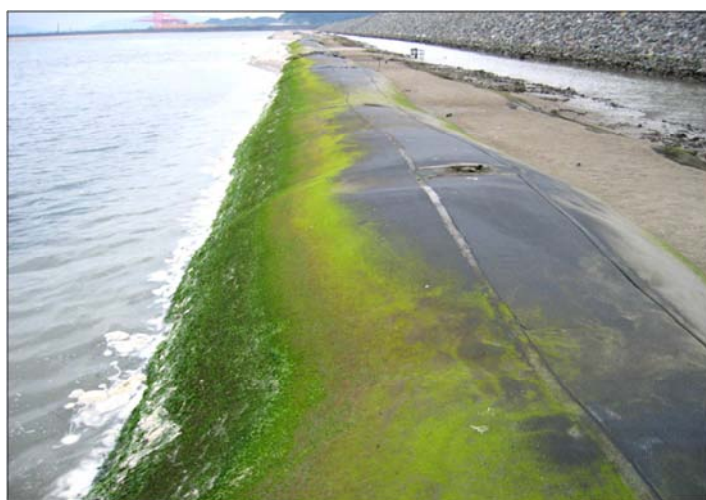
Figura 3.3 – Geocontentor sujeito à acção de algas.
