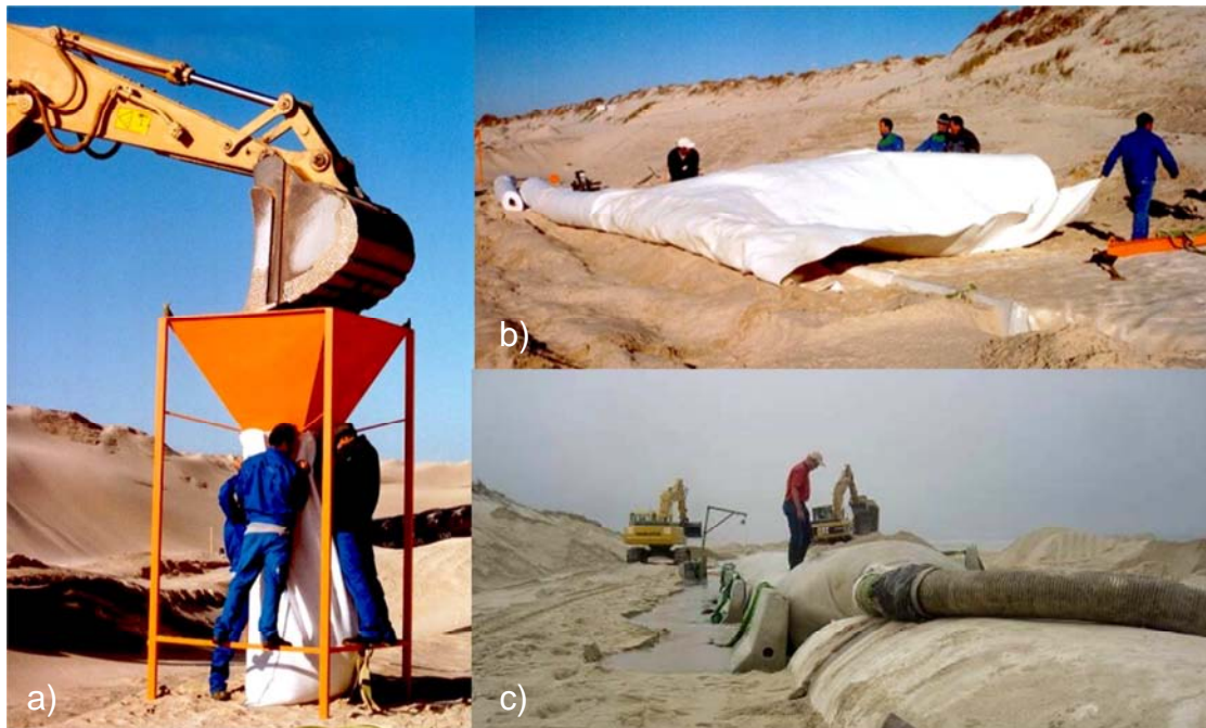
Figura 2.17 – Técnicas de enchimento de geossistemas: a) escavadora e acessórios; b) “wrap-around”; c) bombagem.
