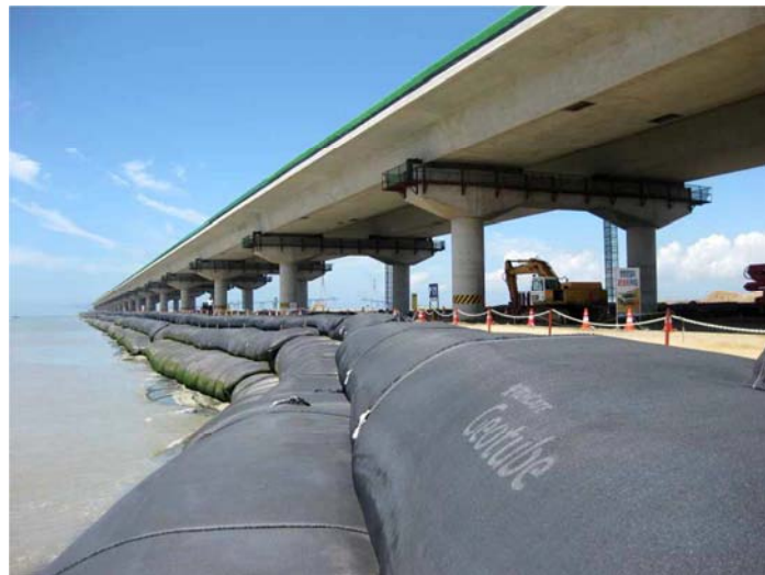
Figura 2.2 – Esquema de revestimento da ilha artificial da ponte de Incheon, Coreia do Sul.
