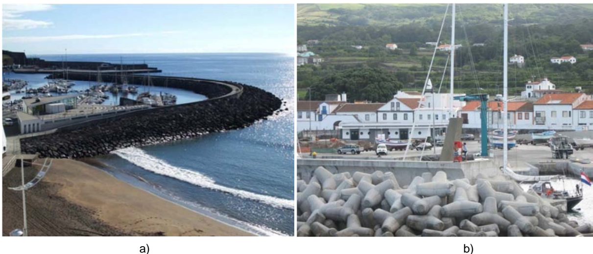
Figura 2.10 – a) quebramar de taludes (marina de Angra do Heroísmo); b) quebramar estrutura mista (marina da Vila da Praia, ilha Graciosa).
