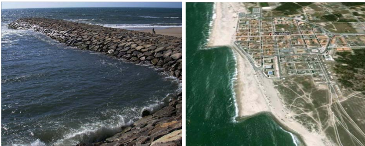
a) b) Fonte: Google Earth, 2010. Figura 2.3 – Esporões: a) norte; b) norte e sul da frente litoral do Furadouro.
