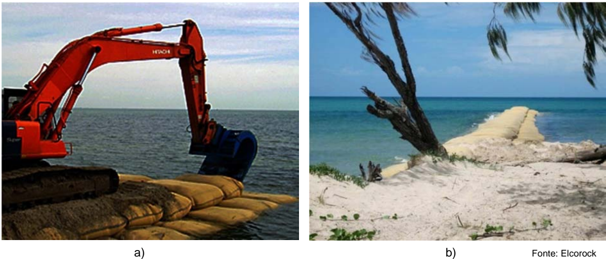
Figura 2.5 – Esporões constituídos por sacos geocontentores na Austrália.
