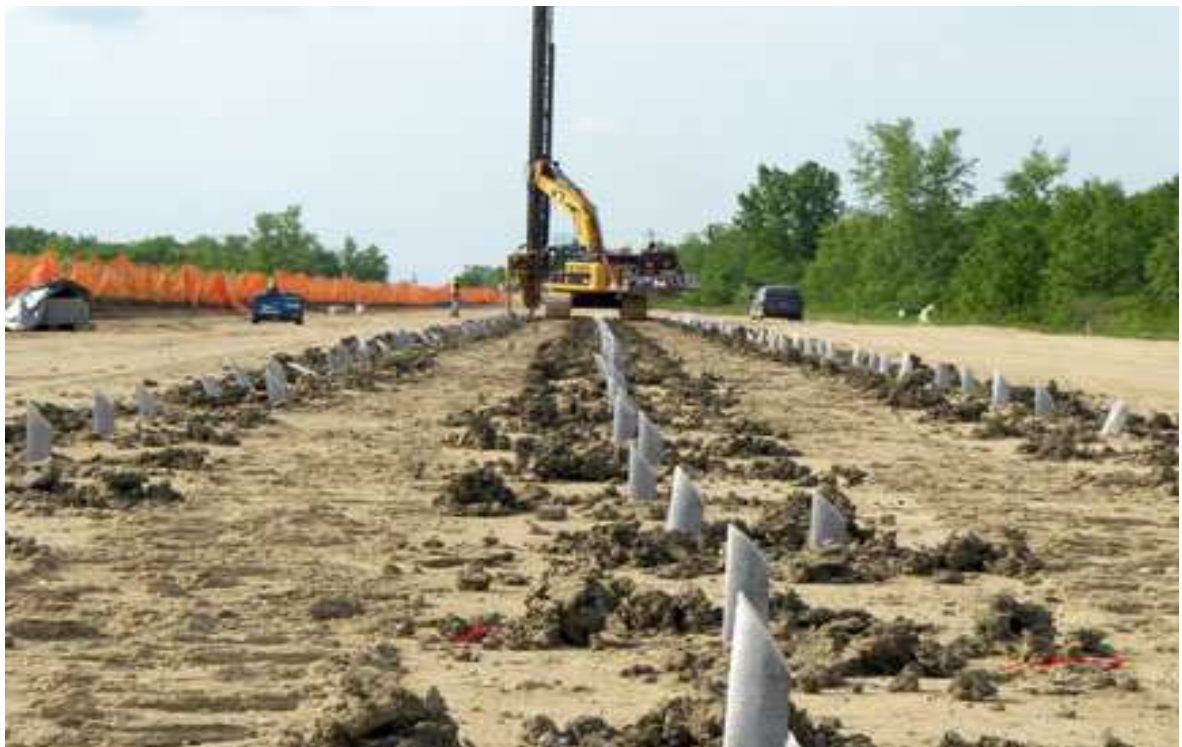
Figura 2.18 – Fotografia do processo de instalação dos drenos pré-fabricados (LayfieldGroup, 2008)
