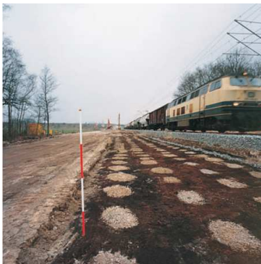
Figura 2.43 – Aspecto final após tratamento por vibrosubstituição (Vibroflotation Group, 2008)
