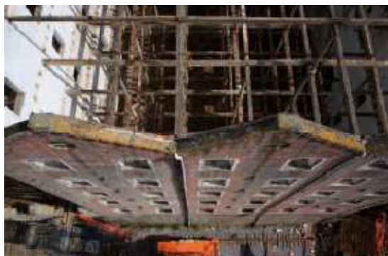
Figura 20 - Aspecto do interior do edifício durante a demolição [Fonte: Melo, 2010]
