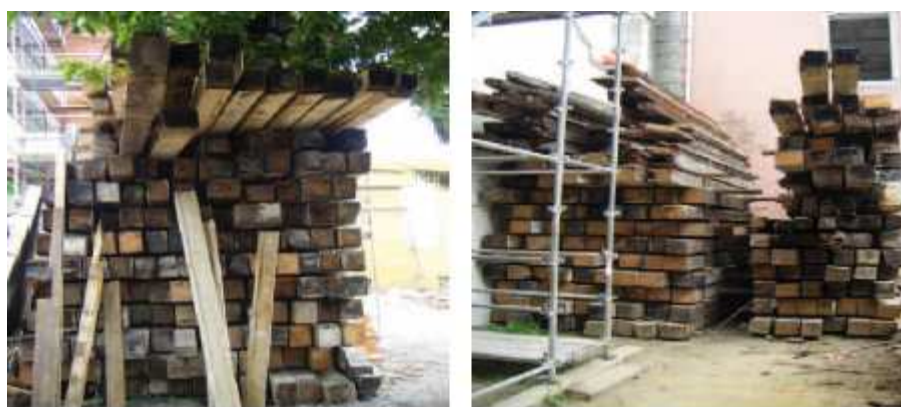
Figura 27 - Madeira resultante do desmantelamento do edifício [Fonte: Melo, 2010]
