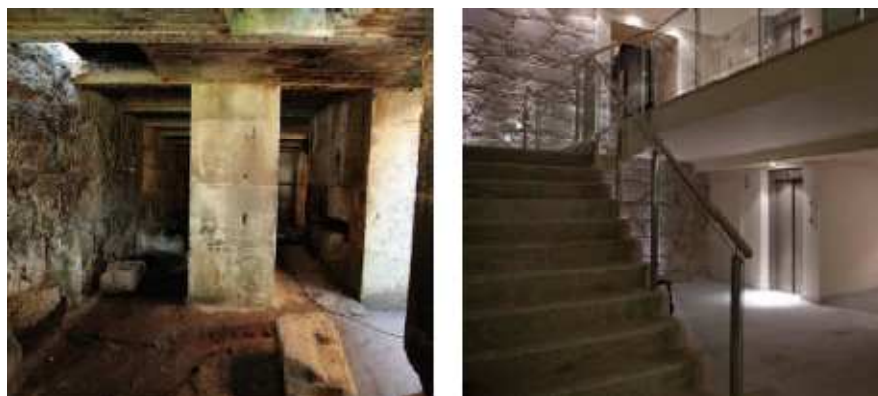
Figura 24 - Lajeado da casa das máquinas, executado com granito proveniente do desmantelamento
