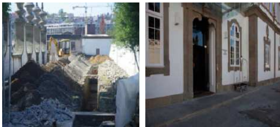
Figura 25 - Reaproveitamento de material escavado, cubos e lajeados [Fonte: Melo, 2010]
