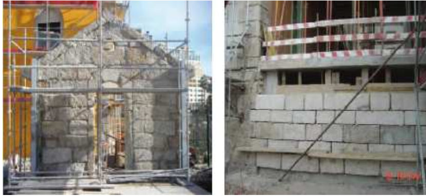
Figura 22 - Reaproveitamento de pedra resultante de desmontes para execução de nova alvenaria
