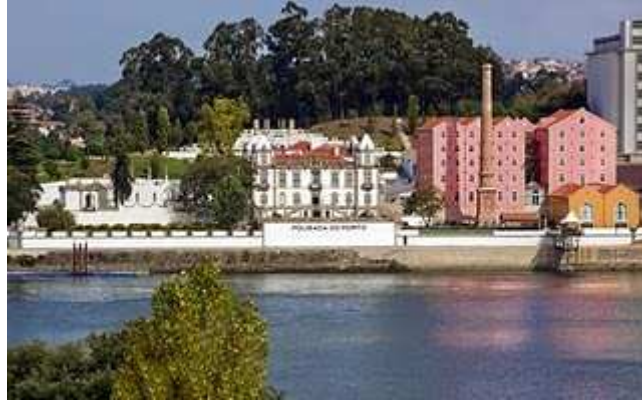
Figura 18 - Vista da Margem Sul do Douro dos edifícios do Palácio do Freixo e das Moagens Harmonia
