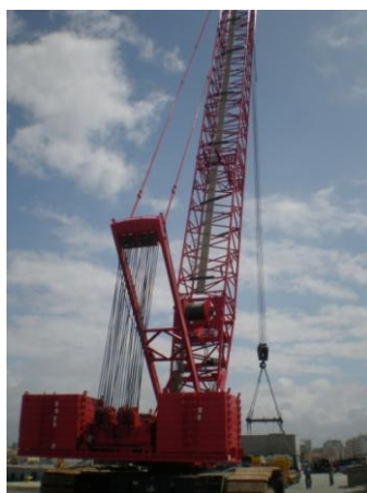
Figura 2.29 - Grua a transportar aduela de betão armado no porto de Leixões
