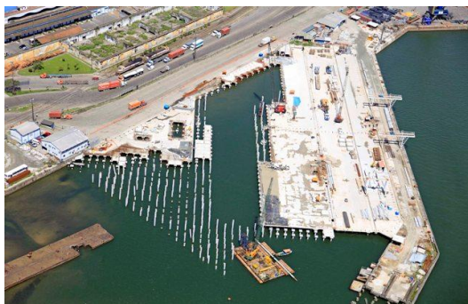
Figura 4.10 - Fundação em estacas e parte da nova plataforma do terminal Tecondi
