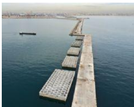
Figura 2.28 - Caixões flutuantes de betão armado no porto de Valência/Espanha
