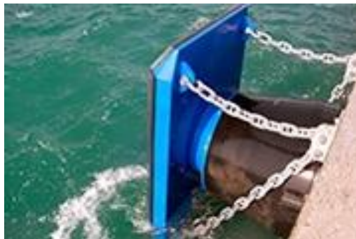
Figura 2.8 - Exemplo de uma defesa cónica.
