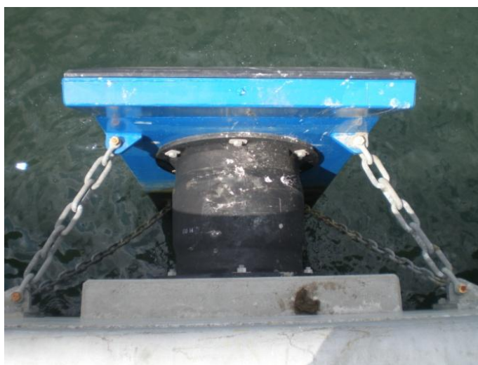
Figura 2.9 - Exemplo de defesa cilíndrica axial.
