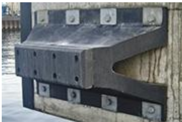
Figura 2.3 - Exemplo de defesa em arco (tipo V).
