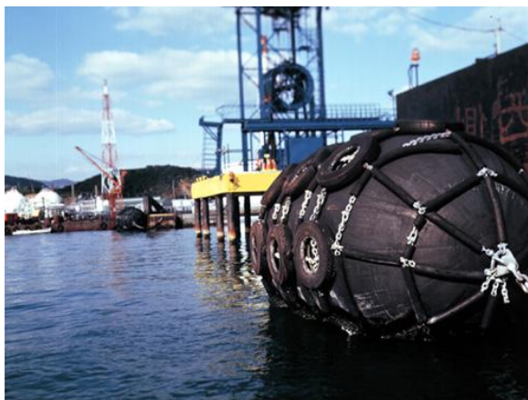
Figura 2.11 - Exemplo de defesa pneumática revestida por pneus e correntes
