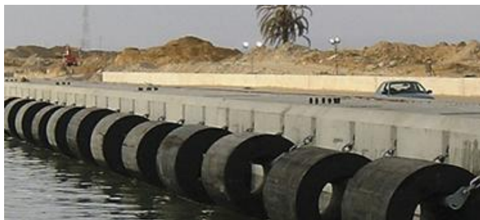
Figura 2.1 - Exemplo de sistema de defensas cilíndricas.
