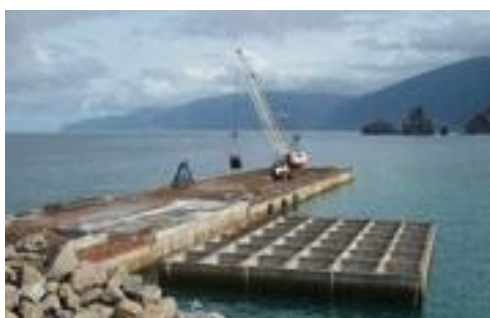
Figura 2.27 - Caixão de betão armado em Porto Moniz/Madeira
