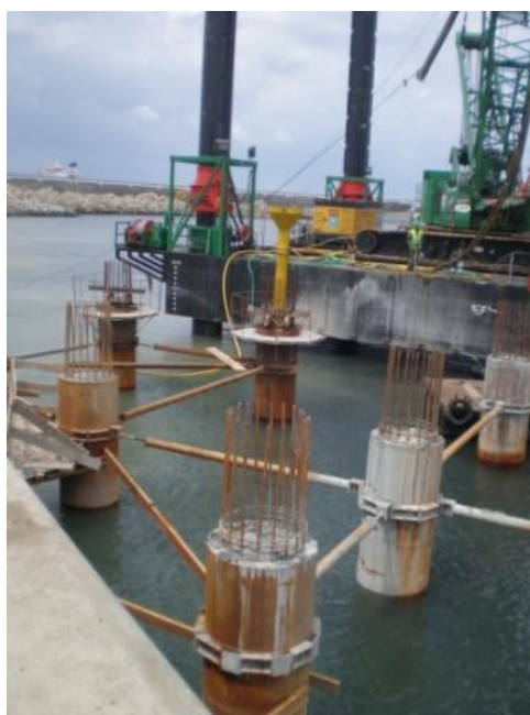
Figura 2.34 - Estacas cravadas no solo no porto de Leixões
