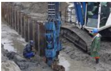
Figura 2.30 - Cravação de estacas-prancha metálicas
