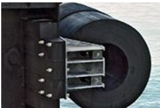
Figura 2.2 - Exemplo de defesa cilíndrica.
