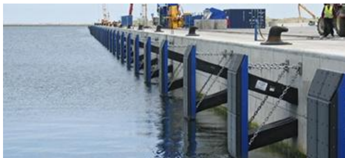
Figura 2.5 - Exemplo de defesa modular (tipo PI).
