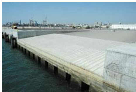
Figura 2.37 – Paramento acostável do novo terminal multiusos do porto de Leixões, em blocos NOREF
