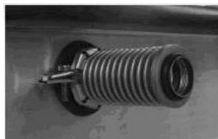
Fig. 18 – Ligação flexíveis para absorver as dilatações dos ciclos térmicos
