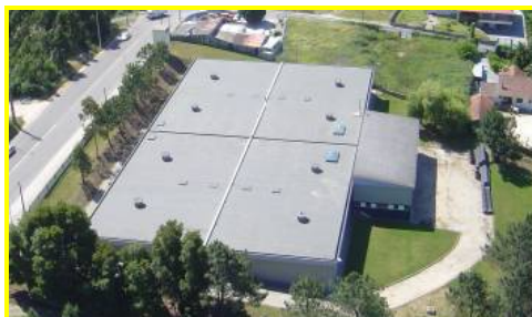
Fig. 8 – Reservatório rectangular apoiado de duas células
