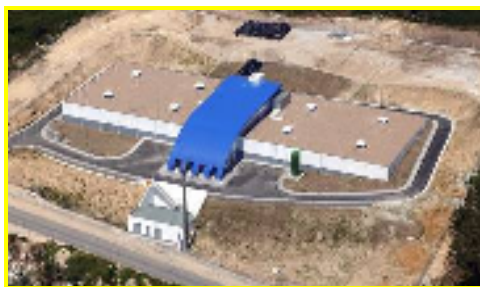
Fig. 7 – Reservatório rectangular apoiado de duas células
