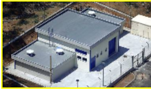
Fig. 2 - Reservatório rectangular apoiado
