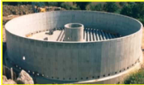
Fig. 3 – Reservatório circular apoiado
