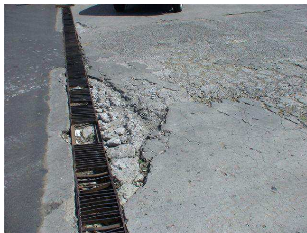
Fig.3.11 – Caleira da placa de abastecimento
