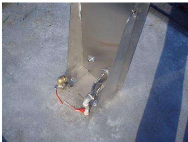
Fig.3.12 – Tomadas de ar e água
