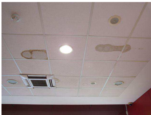
Fig.3.10 – Humidades do tecto da loja de conveniência
