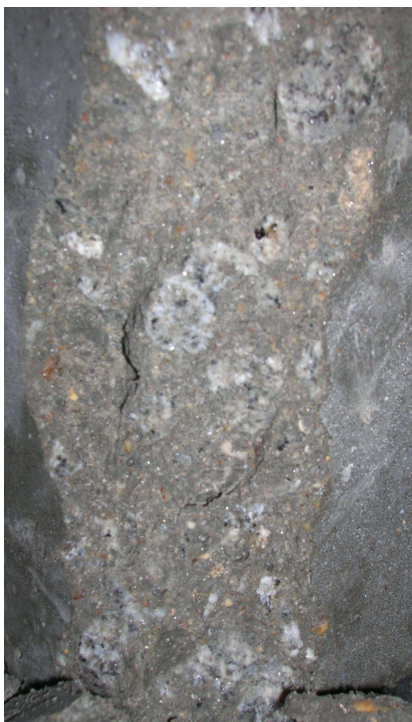
Fig.39 – Aspecto final de um cubo de betão ensaiado à compressão – pormenor de um canto.
