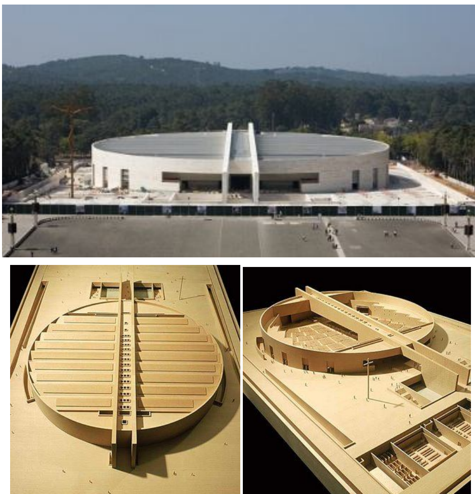
Figura 4.5. – Igreja da Santíssima Trindade pronta (em cima); Maquete da Igreja da Santíssima Trindade (em baixo à esquerda e à direita). [33]
