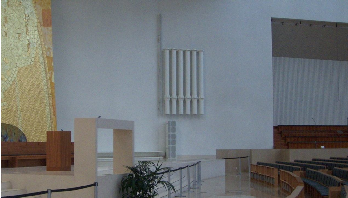
Figura 4.19. – Colunas responsáveis pela amplificação do órgão e Wave Cannons . [Foto do Autor]
