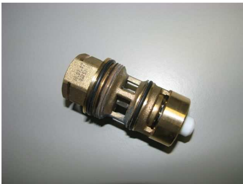
Figura 4.1 - Em cima à esquerda é possível observar a posição do bloco hidráulico e da bomba do protótipo. Em cima à direita um pormenor da bomba e do local onde se encontra a válvula de 3 vias. Em baixo uma vista da válvula de 3 vias, que tem um funcionamento vertical e ao se deslocar provoca a abertura e fecho do circuito de AQS ou AC.
