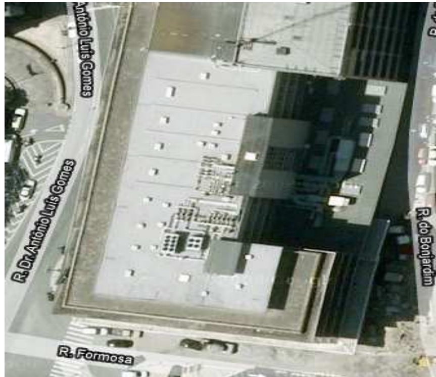
Fig.3. Imagem por satélite do edifício da CM do Porto (Google maps)
