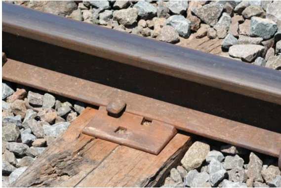
Fig. 4.5 – Palmilha fixa por pregos ou grampos
