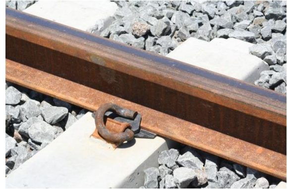
Fig. 4.6 – Palmilha fixa por cliques
