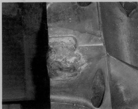
Figura 26 – Enchimento com solda TIG
