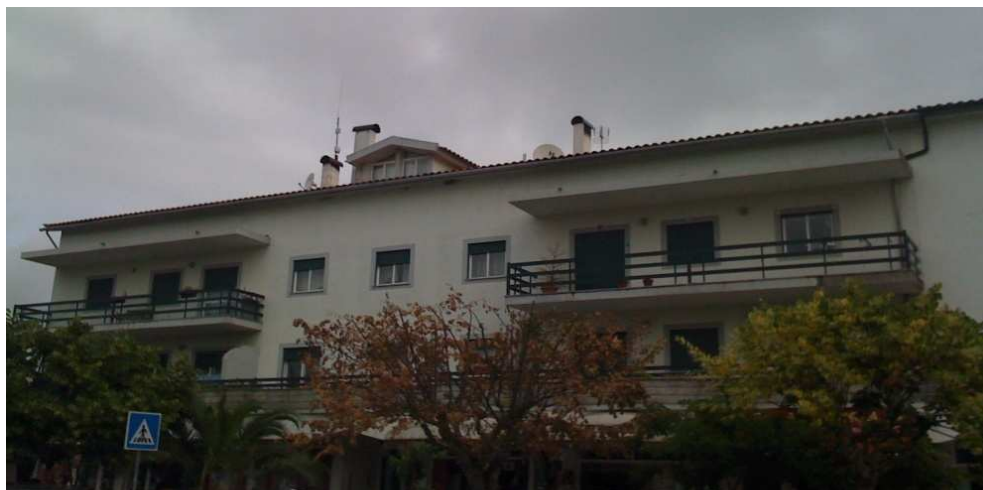
Fig.4.1 – Foto do exterior da fachada do edifício em estudo.
