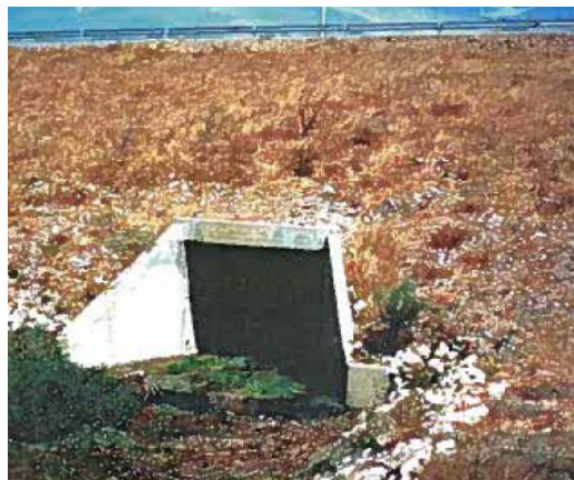
Fig.2.1 – Passagem hidráulica materializada por Box Culverts
