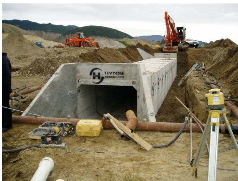
Fig.2.6 – Vala aberta para o assentamento de BC's
