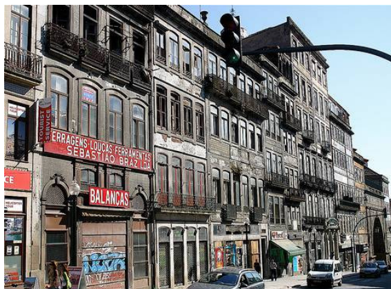
Figura 2-10: Casas da Rua Mouzinho da Silveira, Porto [20]
