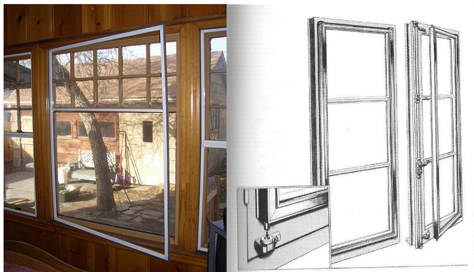
Figura 3-3: Exemplos de folhas adicionais sobre janelas existentes [57] e [9]
