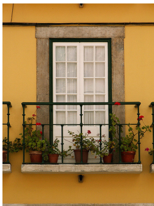
Figura 2-8:Janela de sacada, de batente, com duas folhas, sem bandeira [16]
