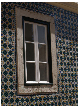
Figura 2-9: Janela de peito, de batente, com duas folhas, sem bandeira [16]
