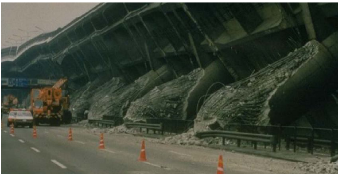
Fig. 3.10 – Viaduto colapsado depois de sismo – adaptado de [3]
