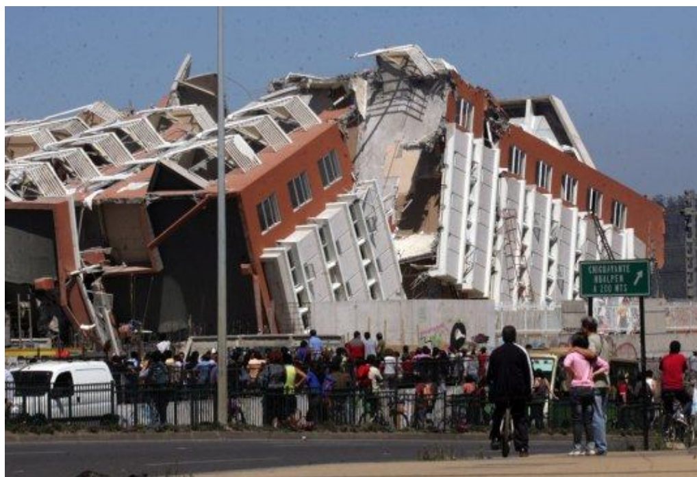
Fig. 3.11 – Colapso de Edifício no Chile - 2010
