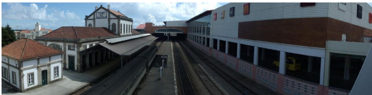
Figura 5.2 – Interface Modal de Viana do Castelo [à esquerda o transporte ferroviário, ao centro e à direita a área comercial e o transporte rodoviário (piso inferior)].
