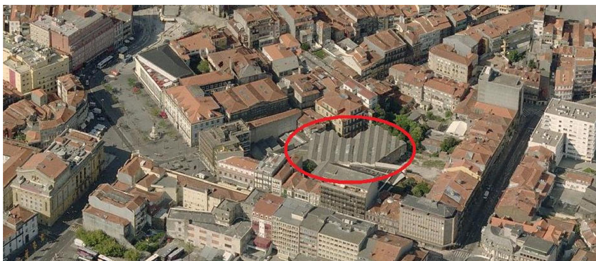
Figura 3.9 – Panorâmica sobre Praça da Batalha, Porto (Fonte: Microsoft Visual Earth )
