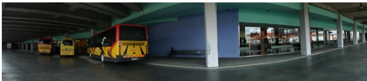
Figura 5.4 – Panorâmica do interior do Terminal Rodoviário (à esquerda estacionamento na diagonal ao passeio e à direita estacionamento executado paralelamente ao passeio)
