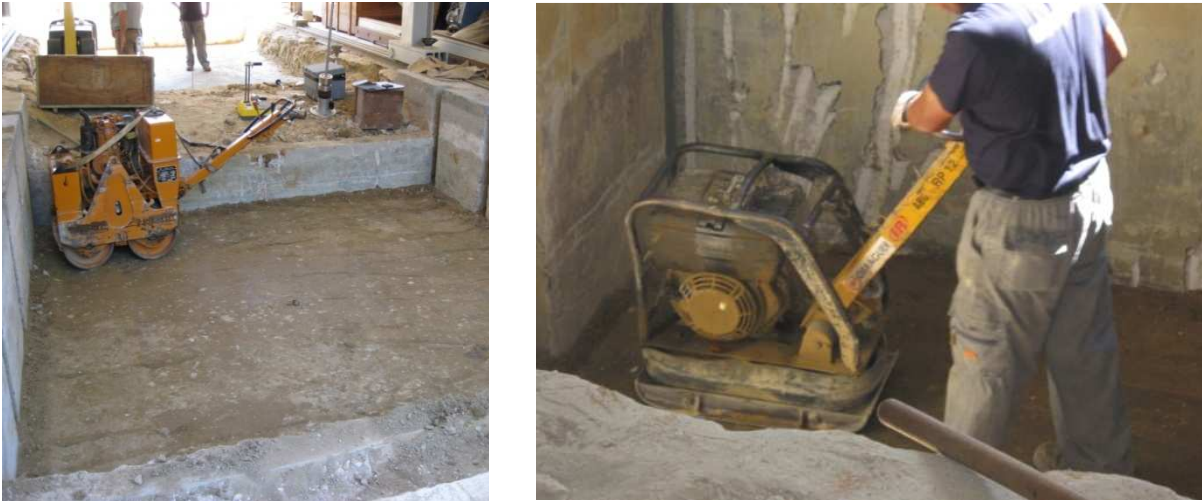
Figura 5. 4: Processo de compactação das camadas de solo.
