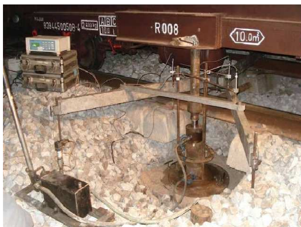
Figura 4. 1: Aspecto do Ensaio de Carga em Placa na caracterização de uma plataforma ferroviária em serviço (adaptado de Geocontrolo, 2004).
