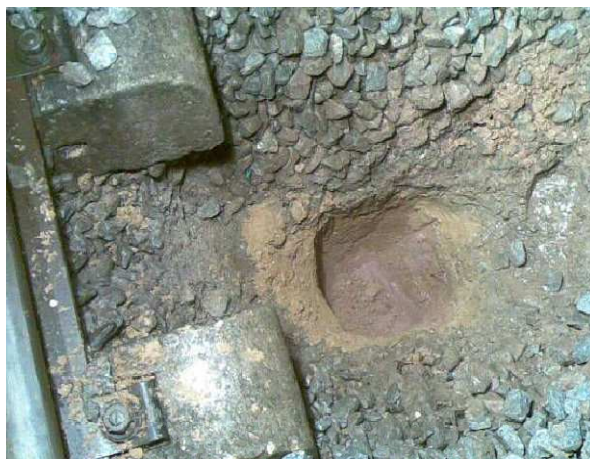
Figura 4. 3: Aspecto da abertura de um poço na plataforma (adaptado de Geocontrolo, 2004).
