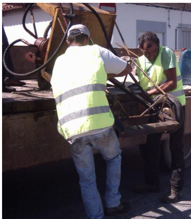
Fig. 24– Manuseamento de espalhadora de emulsão (2)
