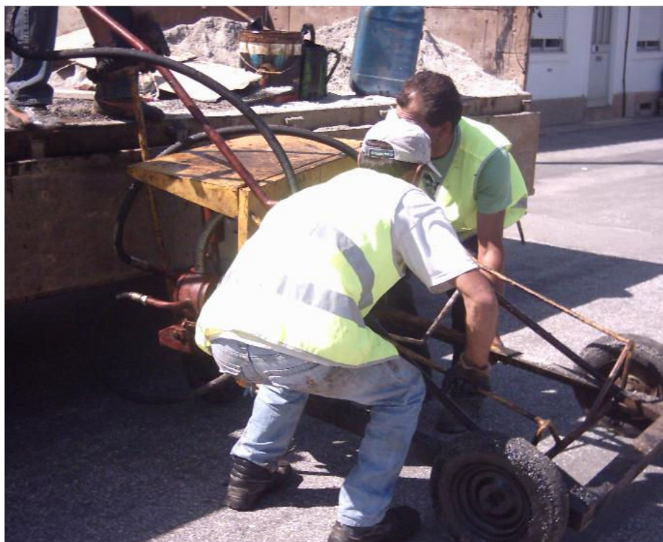
Fig. 23 – Manuseamento de espalhadora de emulsão (1)
