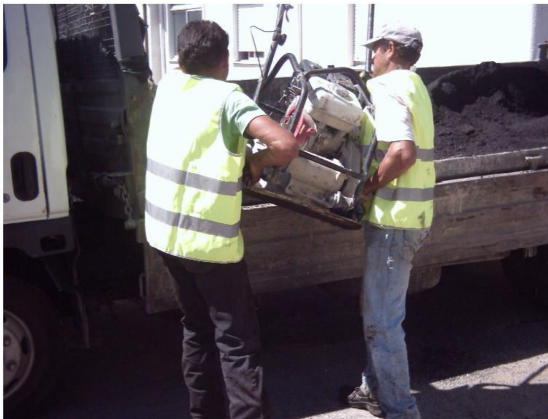
Fig. 26 – Manuseamento de placa vibratória (2)
