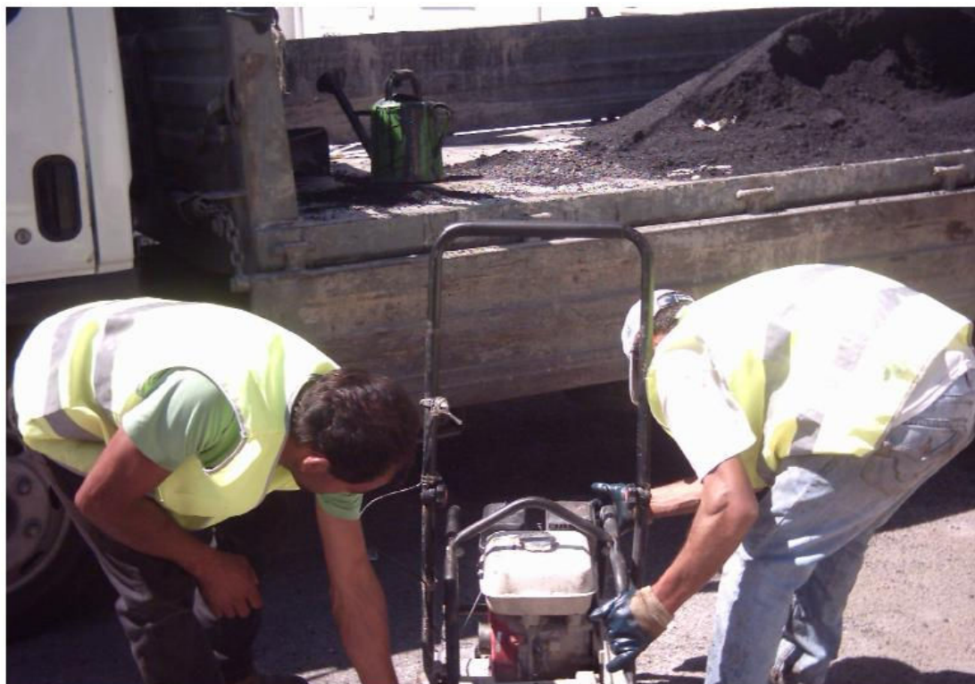
Fig. 25 – Manuseamento de placa vibratória (1)
