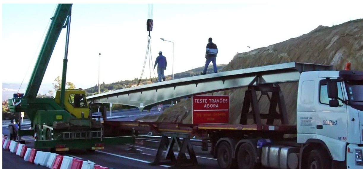
Figura 7.7 – Troço de tabuleiro no momento de chegada à obra
