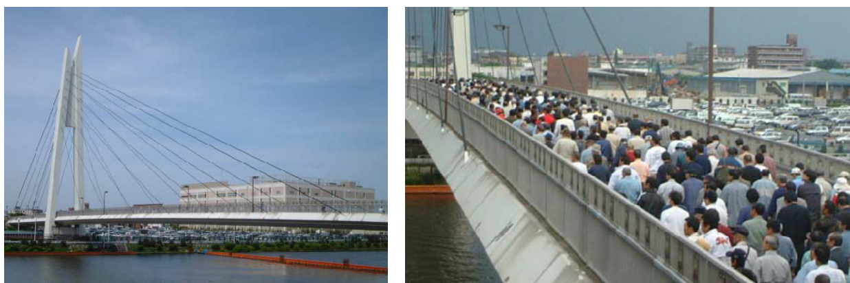
Figura 4.4 – Toda Park Bridge em Tóquio – vista geral da ponte e do atravessamento por uma grande massa de peões, adaptado de [7]
