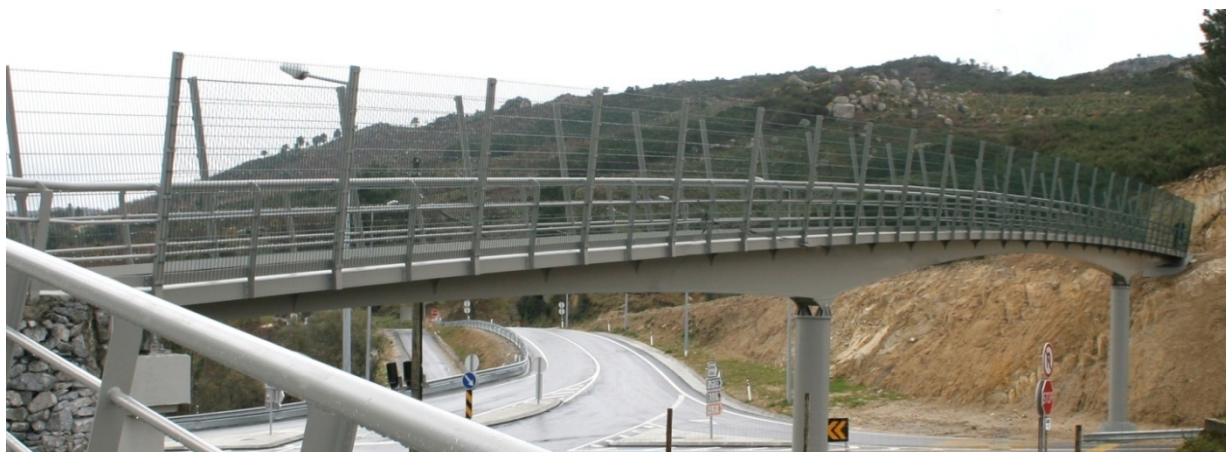
Figura 7.9 – Aspecto geral da ponte após o final da construção
