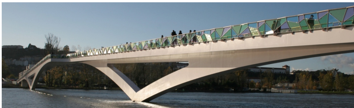
Figura 5.6 – Vista geral da Ponte Pedro e Inês em Coimbra
