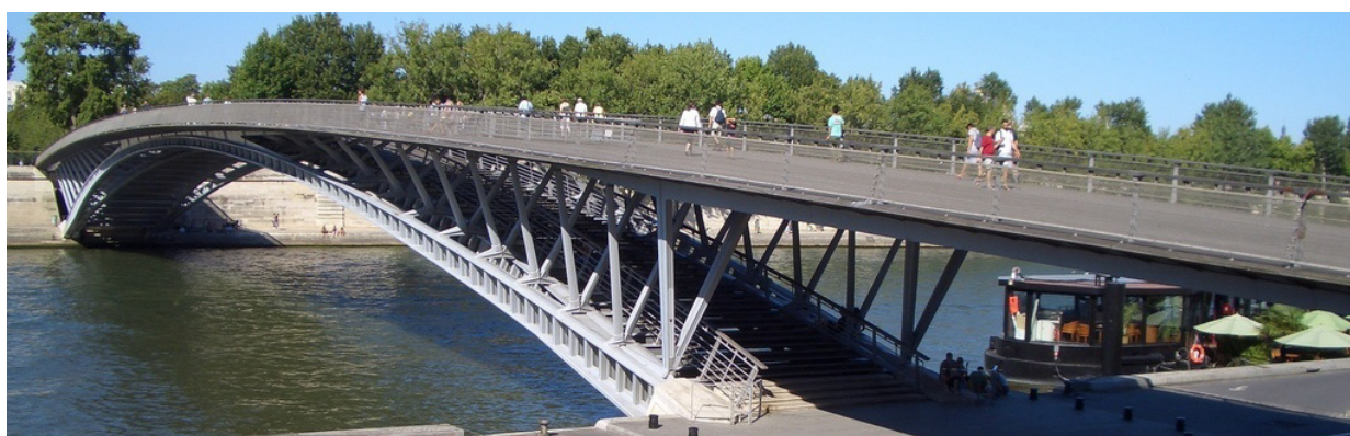
Figura 5.5 – Vista geral da Passerelle Solferino em Paris
