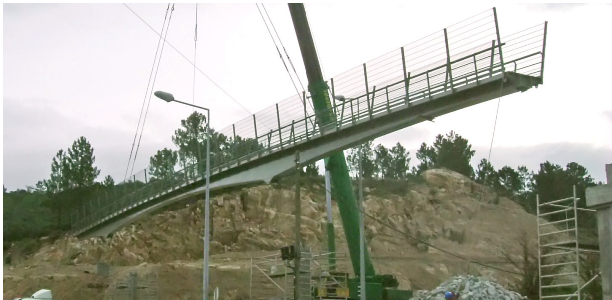
Figura 7.8 – Operação de montagem do tabuleiro da ponte
