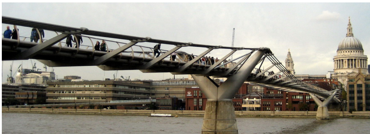
Figura 5.2 – Vista geral da Millennium Bridge em Londres
