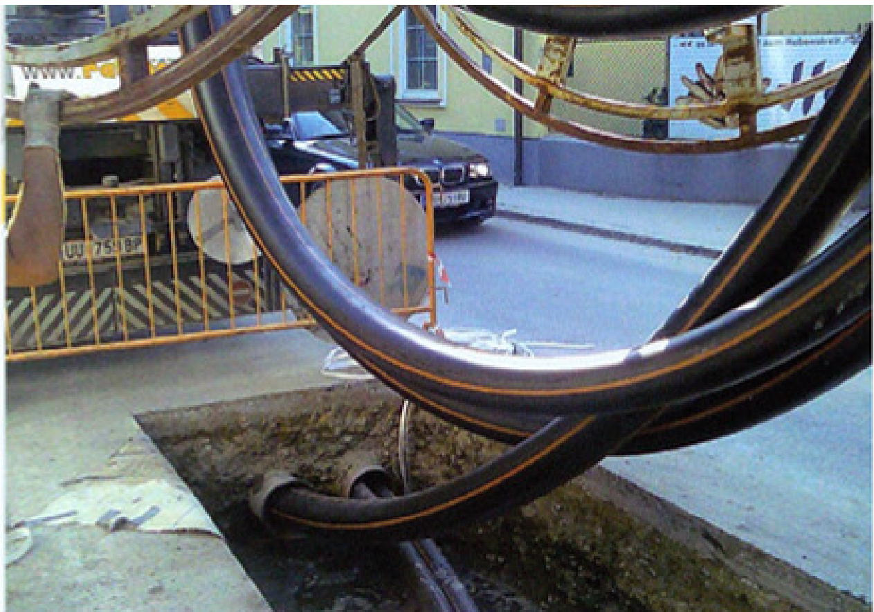
Figura 7 – Encamisamento com Tubo em “U”
