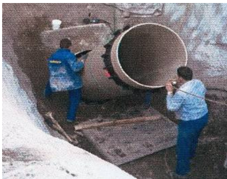
Figura 8 – Encamisamento de Segmentos Curtos
