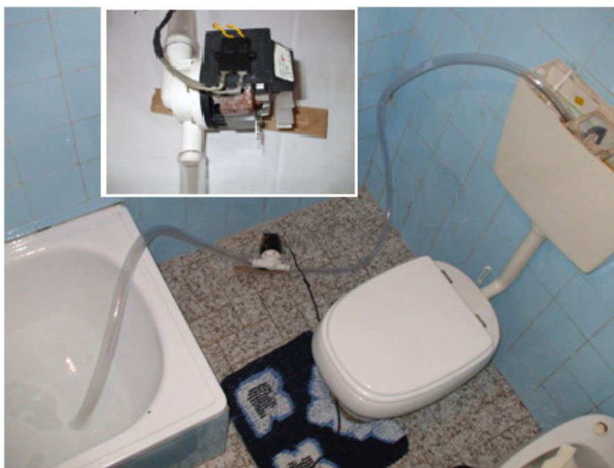
Fig. 7.2. – Reutilização de água de duche na bacia de retrete
