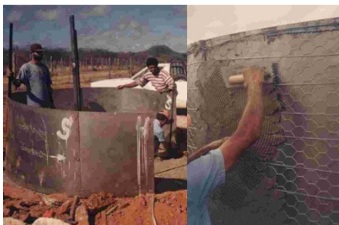
Fig. 2.17 – Construção de uma cisterna de tela e arame
