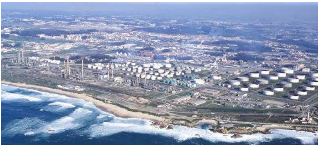
Figura 2.1 - Fotografia aérea da refinaria de Matosinhos [1].
