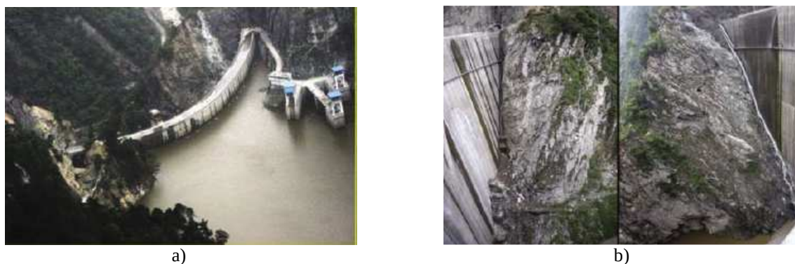
Figura 2.17 – Barragem de Saipai (130 m de altura) após o sismo de Wenchuan: a) foto aérea; b) encontros direito e esquerdo.
