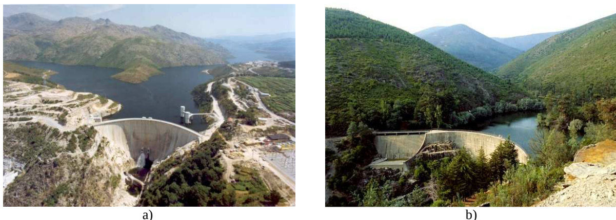
Figura 2.19 – a) Barragem do Alto Lindoso; b) Barragem do Alto Ceira.
