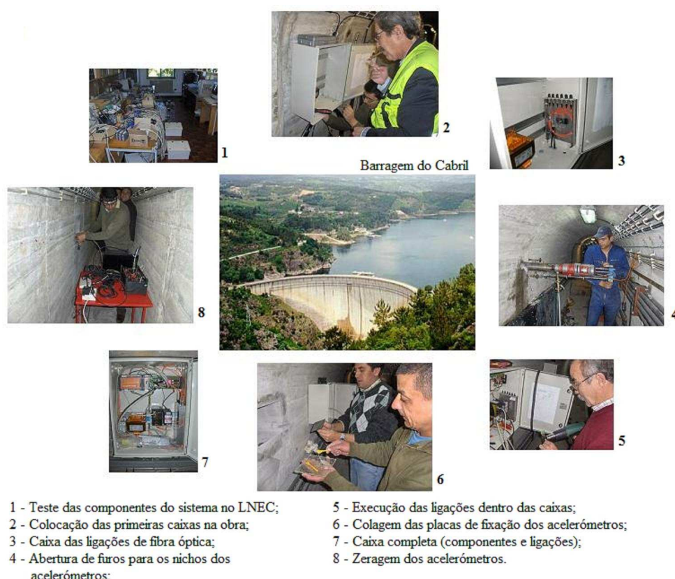
Figura 1.3 – Várias fases do desenvolvimento e instalação do sistema de monitorização em contínuo do comportamento dinâmico da barragem do Cabril.
