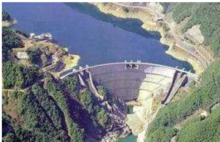
Figura 2.28 – Barragem de Hitotsuse, no Japão.
