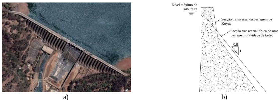
Figura 2.9 – Barragem de Koyna, na Índia: a) Vista aérea; b) Secção transversal.
