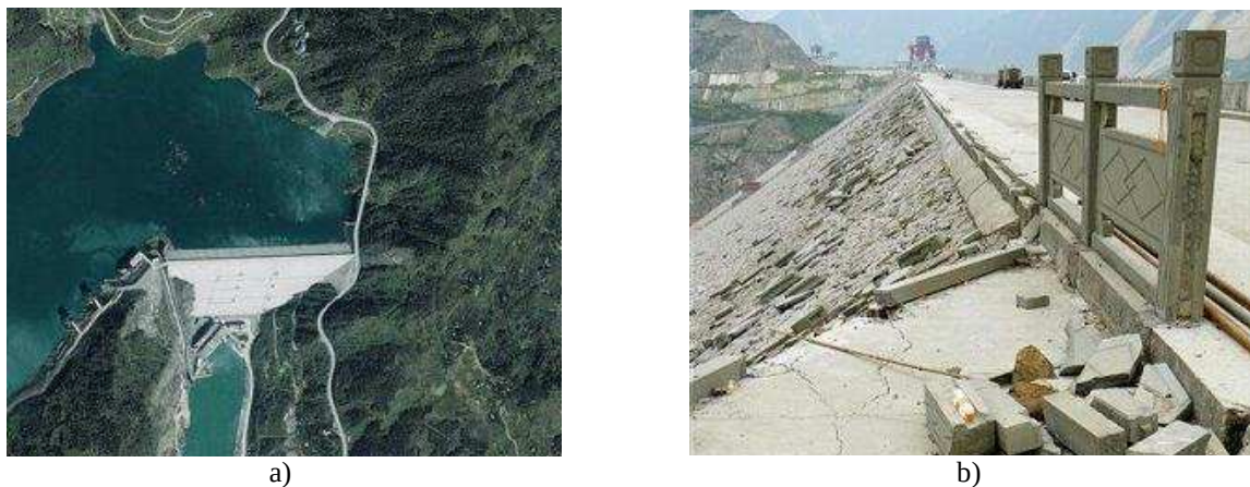
Figura 2.16 – Barragem de ZiPingPu (156 m de altura): a) Imagem de satélite; b) Paramento de jusante, com inúmeros desprendimentos e fissurações.
