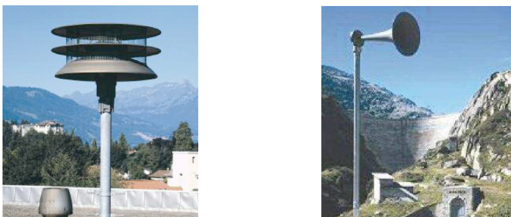
Figura 2.41 – Sirenes para emissão de alarmes para avisar as populações em caso de perigo de inundação (Wieland, et al., 2009).
