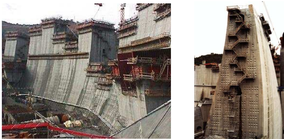
Figura 2.5 Construção de uma barragem abóbada (Alqueva). Vista dos vários blocos na fase de betonagem do corpo da obra e pormenor de uma face das juntas de contracção onde se podem ver os encaixes (“shear boxes”), neste caso com a forma semi-esférica.
