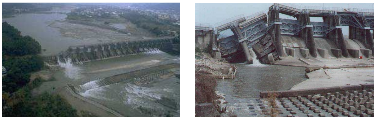
Figura 2.15 – Colapso da Barragem de Shih-Kang, junto à margem direita.
