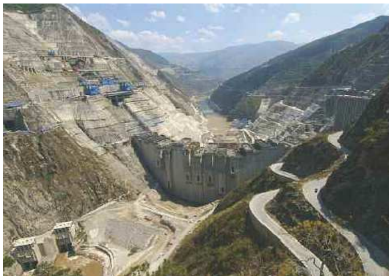
Figura 2.3 – Construção da barragem de Xiaowan (2008) – barragem abóbada com 292 m de altura máxima acima da fundação (Ren, et al., 2007).
