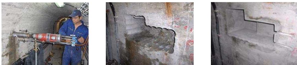
Figura 4.10 – Trabalhos de abertura de nichos para acondicionamento dos acelerómetros.
