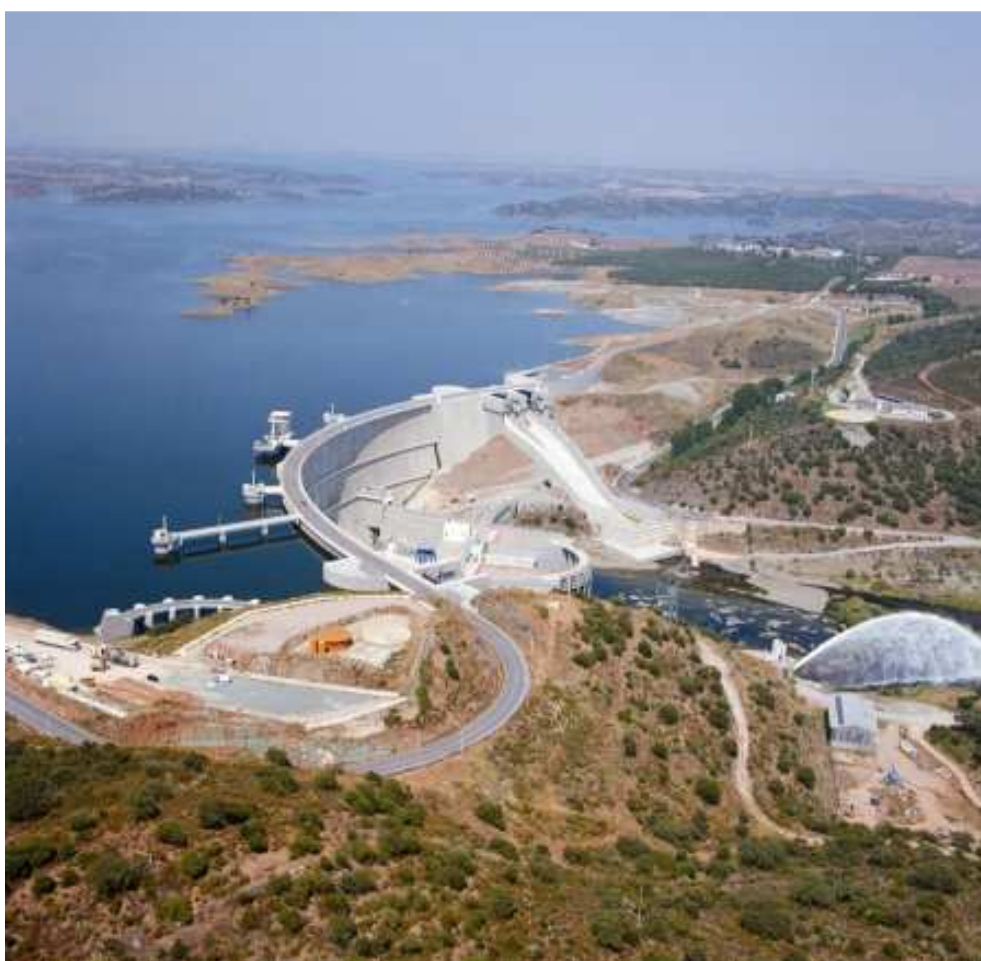
Figura 2.1 Barragem de Alqueva (altura: 96 m; construção:1997-2002; albufeira: 250 km 2 , 4150 hm 3 ). Vista aérea da barragem, albufeira e estruturas anexas.
