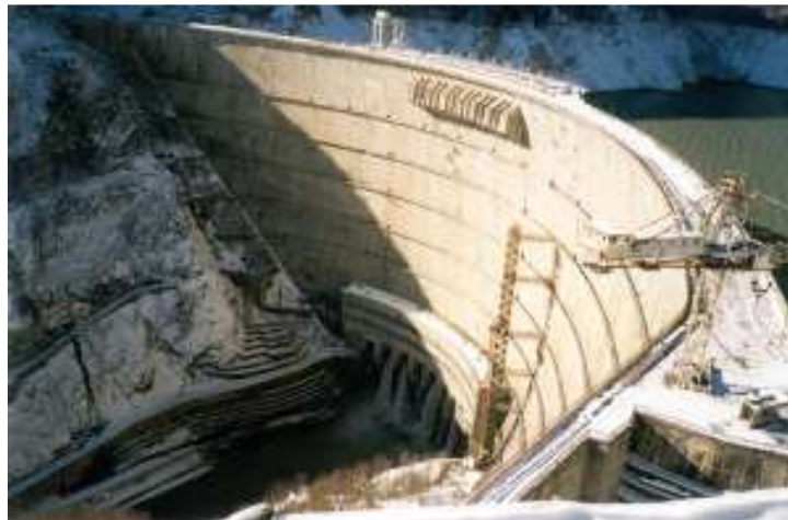
Figura 2.34 – Barragem de Enguri na Geórgia, obras de reabilitação após a guerra civil.
